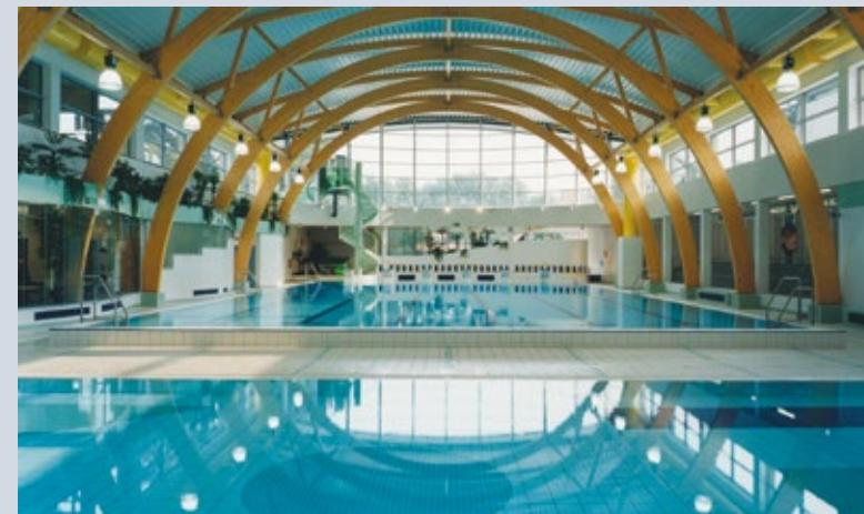
L'Espadon à Etterbeek (Altiplan architectes, 2002) remplace une ancienne piscine construite en 1976 et presque entièrement détruite par un incendie vingt ans plus tard. Pour cette nouvelle construction, les architectes utilisent une charpente en bois, comme celle récemment placée à la piscine de Saint-Gilles. L'économie d'énergie et de consommation d'eau, peu prise en compte jusque-là, joue enfin un rôle important. (© Altiplan)
