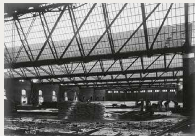
La charpente de l'entrepôt A est terminée et les versants sud des sheds déjà couverts de tuiles. (© AVB)
