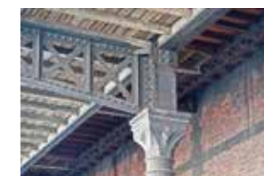
Chapiteau d'une des colonnes soutenant la toiture du quai. (A. de Ville de Goyet © SPRB)
