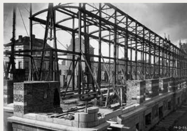
Construction de la charpente métallique du hall central du bâtiment des douanes. (© AVB)
