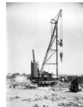
Charpente en bois ou en métal, la sonnette sert au guidage d'une lourde masse de fer ou de fonte appelée mouton. Levé à une hauteur de plusieurs mètres par une machine à vapeur, puis lâché en chute libre, celui-ci, de la force de ses 1.200 kg, enfonce progressivement dans le sol les pilots, longs pieux de bois destinés à assurer la stabilité des fondations dans le sol très humide du site. (© AVB)
