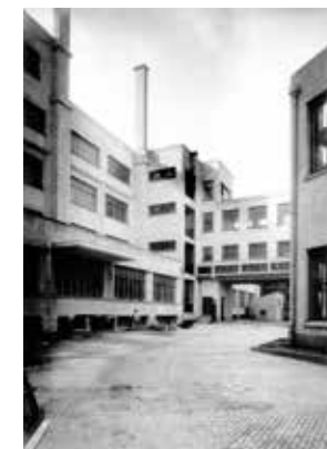
L'usine en voie d'achèvement. (© AVB)
