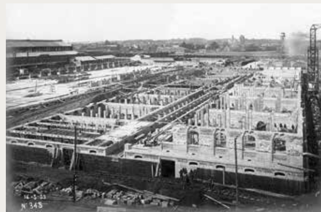
Les fondations de l'entrepôt royal sont achevées ainsi qu'une partie des maçonneries du rez-de-chaussée. À gauche, le long de la gare de marchandises, on distingue le sol du futur entrepôt A. Dans le lointain se profile la silhouette de l'église de Laeken. (© AVB)
