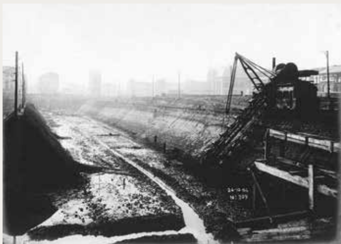
Dans la seconde partie des fouilles de l'entrepôt, installation et mise en marche d'un excavateur, drague dont la chaîne à godets, mise en mouvement par une machine à vapeur, entame le talus en y creusant des sillons. Les godets de la chaîne qui se sont remplis de terre et de déblais viennent se vider derrière l'excavateur. (© AVB)
