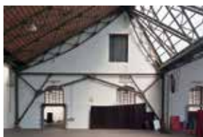
Détail de la charpente articulée des sheds. (A. de Ville de Goyet © SPRB)
