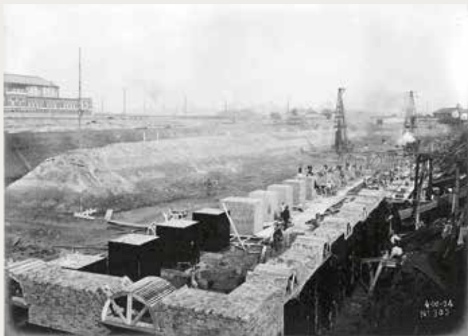
Les premiers pilastres en maçonnerie de l'entrepôt public en cours de construction alors que plus loin les sonnettes battent les pilots des fondations. (© AVB)
