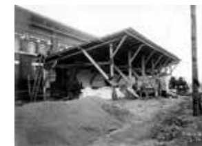
Installations pour le broyage des mortiers à l'électricité. (© AVB)
