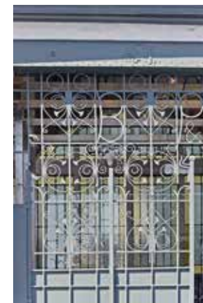
Détail de la grille d'entrée. (A. de Ville de Goyet © SPRB)
