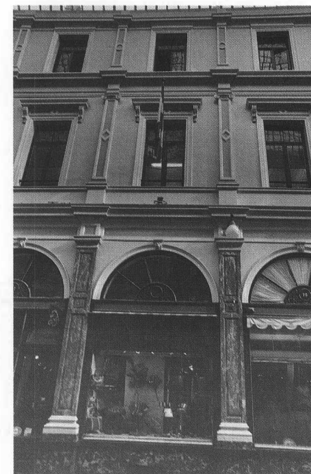
L'élévation à trois étages assortie du principe de la superposition des trois ordres comme dans les façades à rue.
