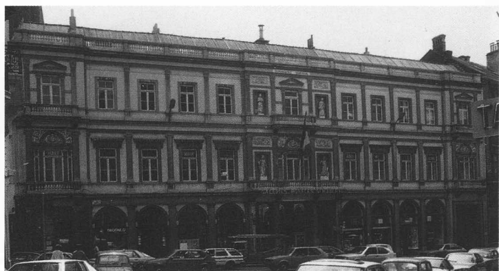
La galerie du Roi, terminée au nord par une façade de treize travées, rue de l'Ecuyer.
