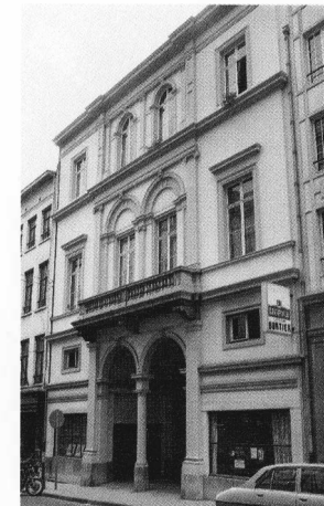
Rue Saint-Jean. Entrée de l'architecte J.-P. Cluysenaar vers le marché de la Madeleine et la galerie Bortier.
