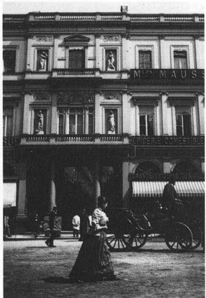
Façade externe des galeries.
