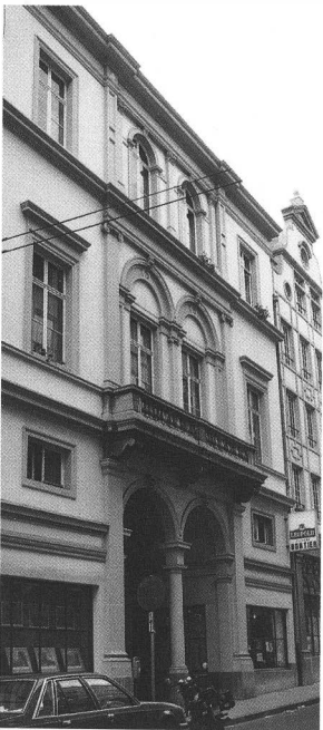
Façade rue Saint-Jean.
