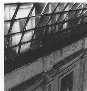
Le niveau des mansardes, derrière la verrière.
