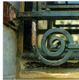
Bois non protégé lors du nettoyage de la façade
