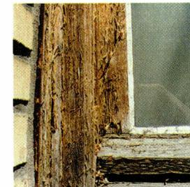
Dégradation du vernis due à la mauvaise neutralisation du décapant
