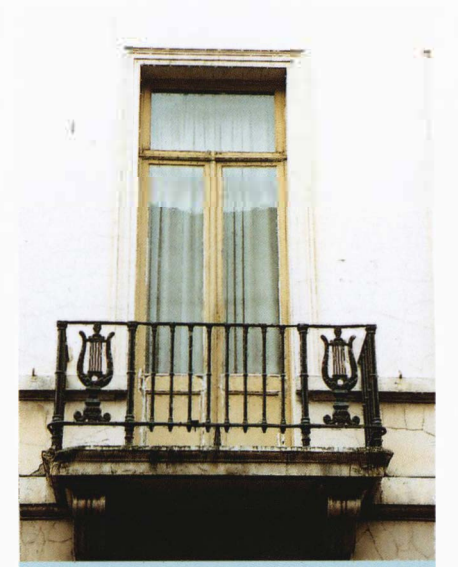
Fenêtre, rue Traversière 34, Saint-Josse-ten-Noode.
