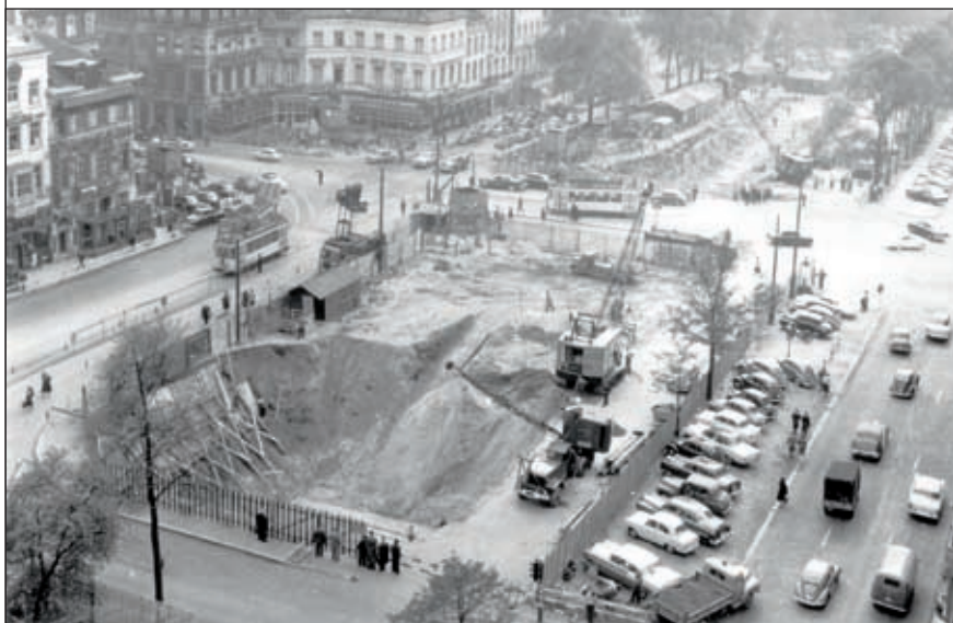
▲ Creusement du tunnel sous la place Louise, 1956.
