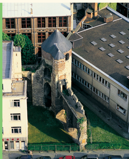
Tour Anneessens, 2004 Anneessenstoren, 2004
