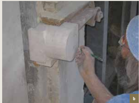
De Roose. Eerste verdieping, restauratie van een voluut van een kapiteel: a) integratie van een inzetstuk in Massangis; b) het sculpteren van het inzetstuk; c) afgewerkt element (© CHE, 2008).
