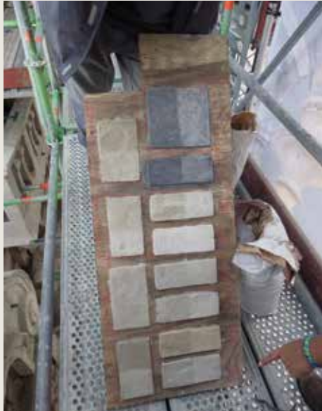
Stalen van herstellingsmortel, om te vergelijken met de te herstellen stenen en om de textuur, granulometrie en kleur te bepalen. Dit stalenpalet is steeds aanwezig op de werf (© CHE, 2014).
