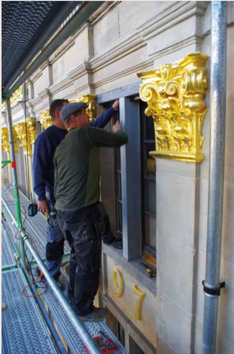
Den Engel. Plaatsing van valse monelen uit beschilderd hout dat hardsteen imiteert. Deze kunnen gedemonteerd worden bij verhuizingen (© CHE, 2008).
