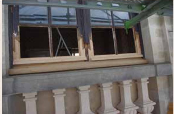
De Duive. Vervanging van de onderdorpels en waterlijsten en plaatsing van inzetstukken. Eik (© CHE, 2008).
