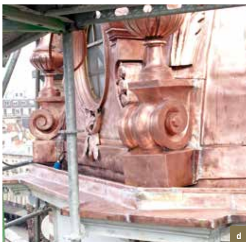
Den Coninck Van Spaignien . Verschillende stappen van de restauratie van de koperen koepel. a) toestand voor de restauratie, met vervuiling en groene patina; b en c) alle koperen elementen worden gezandstraald om het koper bloot te leggen en te restaureren, dat wil zeggen dat beschadigde stukken werden vervangen en beschadigd laswerk werd hersteld; d) reinigen en polijsten met staalwol (© CHE, 2015).
