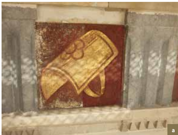
De Wolvin. Detail van de metopen met vergulde motieven op de fries die verwijzen naar het boogschieten. a) restauratietest op het rechtergedeelte; b) het uiteindelijke resultaat (© CHE, 2014-2015).
