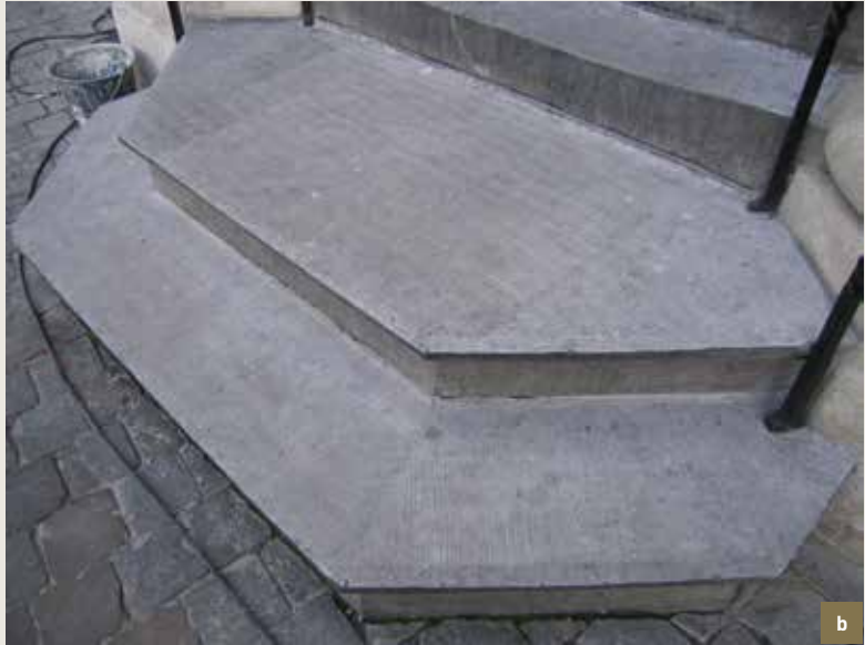
De Swane. a) het ciseleren van de toegangstrap op basis van bestaand model. Arduin; b) voltooid werk (© CHE, 2008).
