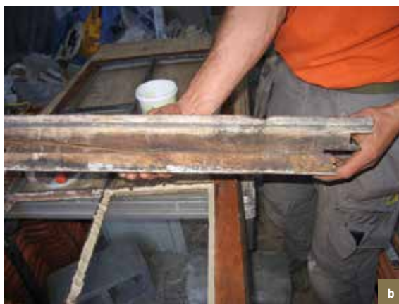
De Roose. Verwerde elementen in eik. a) een te vervangen waterlijst (onderste gedeelte van het raamwerk); b) een te vervangen onderdorpel (© CHE, 2014).
