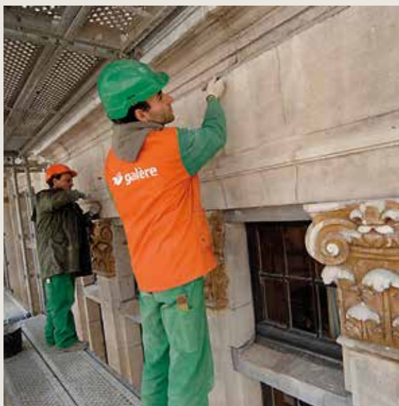
De Sterre . Opvoering met mortel (© Daylight, 2008).
