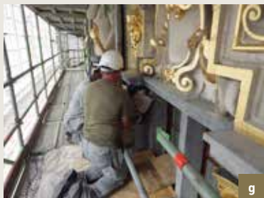
Den Sack. Verschillende fasen van de reconstructie van een kapiteel: a) beschadigde toestand; b) demontage van het element; c) het maken van een afgietsel van een kapiteel in goede staat; d) gietvorm in silicone en schelp in polyester met glasvezelbewapening; e) positief in gips; f) nieuwe sculptuur in Savonnièresteen; g) integratie van het stenen element (© CHE, 2014-2015).
