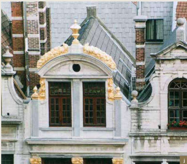
Den Ezel. Verschillende fasen van de restauratie van het gebogen fronton, van de toestand voor restauratie tot de voltooiing. Euvillesteen. a) vervallen toestand; b) demontage; c) oude nummering van de stenen en gecorrodeerd anker; d) nieuwe markering van de stenen voor demontage; e) wegnemen van de gecorrodeerde metalen liggers; f) plaatsing van nieuwe metalen liggers; g) reiniging en restauratie van de stenen in het atelier; h en i) opnieuw monteren van de gerestaureerde elementen; j) totaalbeeld na de werken (© CHE, 2003-2004).
