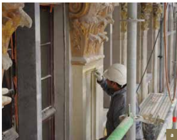
De Gulden Boot . a en b) het aanbrengen van bepleistering op een kolossale pilaster (© CHE, 2012).
