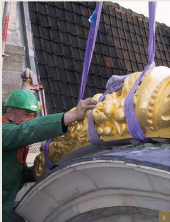
Den Ezel. De verschillende stappen voor de vervanging van de hoorns des overvloeds van de geveltop. a) toestand van de Euvillesteen voor demontage; b) de erg beschadigde hoorns des overvloeds worden op basis van oude foto's in het atelier met gips gerepareerd. Deze stukken fungeren als model voor de nieuwe elementen; c) met behulp van een driepuntpasser wordt het model gekopieerd in Euvillesteen ; d) een van de afgewerkte nieuwe elementen; e) een van de beelden verguld met bladgoud; f) eens ze afgewerkt zijn, worden de hoorns des overvloeds met een kraan naar boven gehesen en zorgvuldig gemonteerd. (© CHE, 2003-2004).
