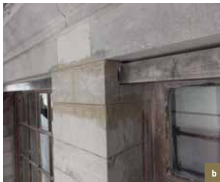
Sint Barbara. a) detail van de te vervangen steen, gemarkeerd met rood krijt; b) nieuwe metalen lateien in roestvrij staal en nieuwe Gobertangestein (© CHE, 2015).
