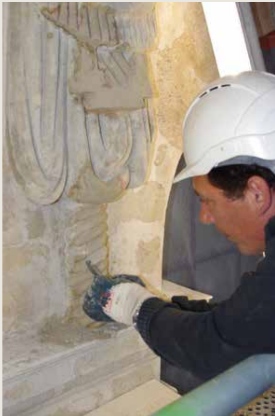
De Duive . Restauratie van een getorst element van een mascarón met herstellingsmortel. Niet geïdentificeerde steen (© CHE, 2012).
