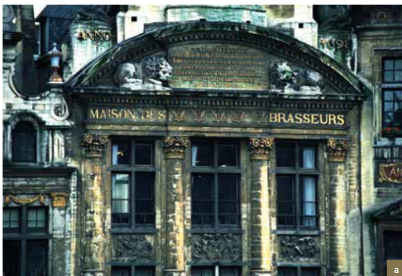
Het Brouwershuis. Details van een van de panelen op de borstwering van de tweede verdieping met een voorstelling van de wijnoogst (Pierre Van Dievoet, 1698). Waarschijnlijk in Avendersteen. a) verontreinigde putti-sculpturen voor de restauratie, met links gedeeltelijke reiniging; b) applicatie van kompressen met cellulosepasta op basis van ammoniak, om de zwarte korsten zacht te maken; c) verfijning van de reiniging met een micro-zandstraalapparaat; d) toestand na reiniging (© CHE, 2004).
