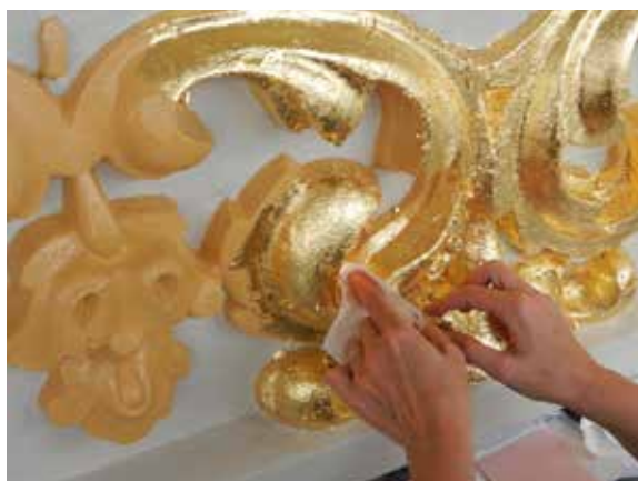
De Gulden Boot. Detail van de fries van het fronton tijdens het vergulden met bladgoud (© CHE, 2012).
