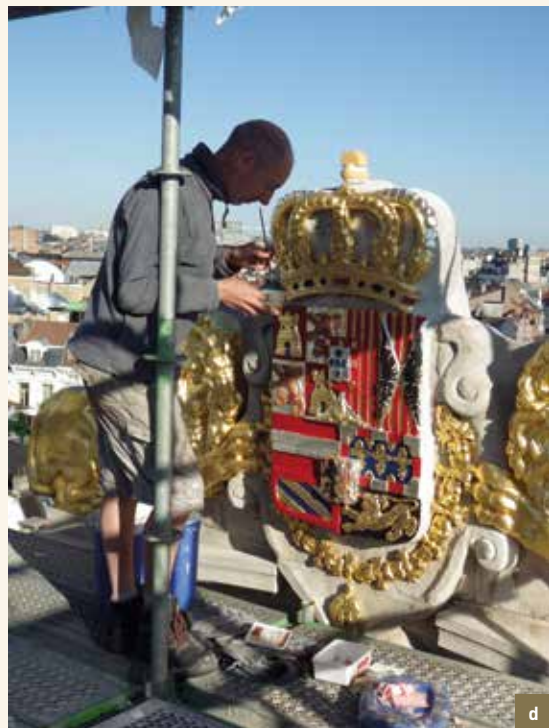
Den Horen. Verschillende fasen van de restauratie van het gepolychromeerde wapenschild op basis van een oorspronkelijk document. a) voor reiniging; b) na reiniging; c) archiefdocument waarin de pigmenten van het schild worden aangegeven; d) restauratie en reconstructie van de polychromie; e) bijna afgewerkt element. Naast de polychromie zijn er vergulde – of nog te vergulden – elementen te zien, naast elementen bedekt met bladzilver; de restauratie gebeurde op basis van de instructies van het archiefdocument (© SAB en CHE, 2014-2015).
