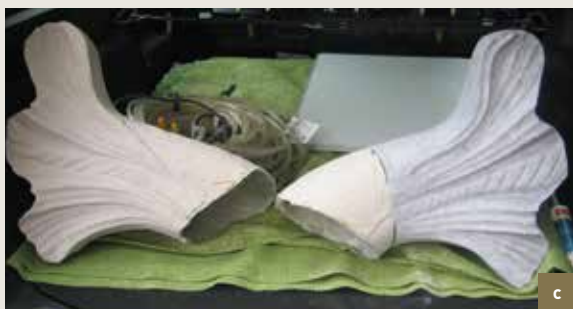
Het Brouwershuis . Detail van de hardstenen dolfinen op de geveltop. a) links hardstenen dolfin die als model dient voor het ontbrekende stuk van de dolfin rechts; b) rechterdolfin met ontbrekende staartvin; c) afgietsel van de staartvin van de linkerdolfin en nieuw element in hardsteen ter vervanging van het ontbrekende stuk van de rechterdolfin. Afgietsel in polysterhars gewapend met glasvezel en nieuwe sculptuur in hardsteen; d) het nieuwe hardstenen element geplaatst op de rechterdolfin (© CHE, 2008).
