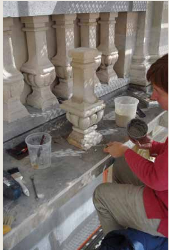
De Duive . Restauratie van een balusterdetail, reparatie met herstellingsmortel. Euvillesteen van het Marbrier-type (© CHE, 2012).
