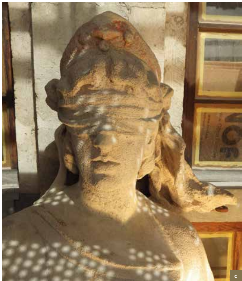
De Vos . Detail van het beeld Justitia (Pierre Comein, 1884). Euvillesteen. a) voor reiniging. Vervuiling, barst ter hoogte van het hoofd; b) na reiniging; c) na restauratie van de steen (hechting van het gebarsten hoofd, herstelling met mortel op basis van foto's van de modellen) [© CHE, 2014-2015].
