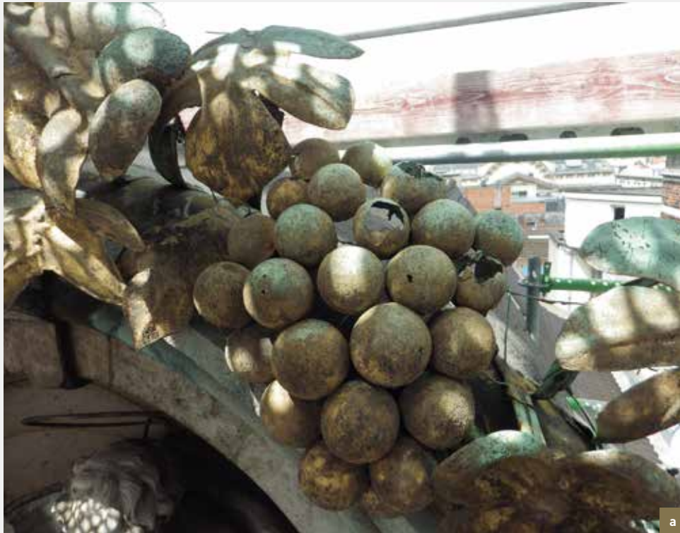
Den Cruywagen. Verschillende fasen van de restauratie van de koperen guirlandes. a) toestand voor restauratie (de druiventrossen zijn sterk gecorrodeerd en soms vertonen ze gaten); b, c, d en e) restauratie in het atelier (met nummering), het gladschuren met staalwol en reiniging met gedemineraliseerd water en aceton; opvulling van de lacunes (epoxy) en vergulding (© CHE, 2014-2015).
