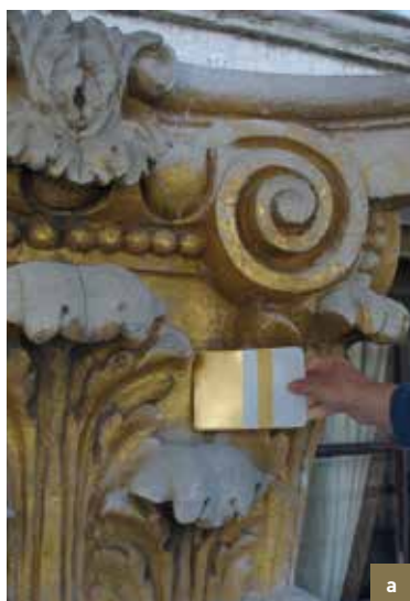
De Gulden Boot. Detail van een kapiteel. a) controle van de keuze van het verguldsel; b) links, oranje-gele grondlaag; rechts het plaatsten van het bladgoud op een hechtlaag (mixtion) (© CHE, 2012).
