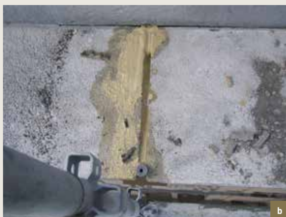
Den Ezel . Dorpel in hardsteen. Injectie van het product (twee componenten epoxy) in de speciaal hiervoor gemaakte kleine gaatjes (© CHE, 2003-2004).
