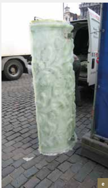
Het Brouwershuis. Zuil met torsade van gebladerte. a) de metalen onderdelen deden het element barsten of breken (gecementeerd op oorspronkelijke steen). Beschadigde toestand voor moulage en restauratie; b) proefboring om een staal te nemen van de gecementeerde elementen; c) het maken van een afgietsel in silicone; d) schelp in polyesterhars versterkt met glasvezel; e) het afgietsel wordt getransporteerd met het oog op een eventuele reconstructie; f) uiteindelijk werden de elementen ter plaatse gerestaureerd, geschilderd en met bladgoud verguld (© CHE, 2014-2015).
