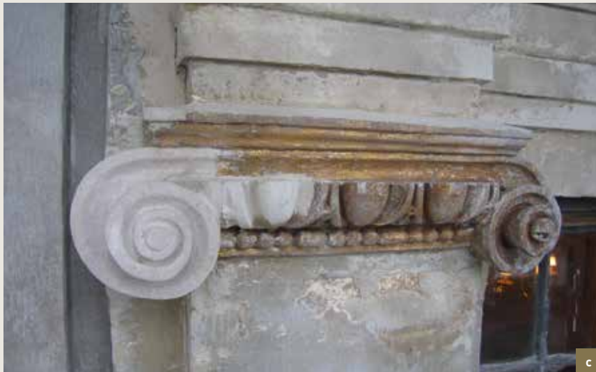
De Roose. Eerste verdieping, restauratie van een voluut van een kapiteel: a) integratie van een inzetstuk in Massangis; b) het sculpteren van het inzetstuk; c) afgewerkt element (© CHE, 2008).
