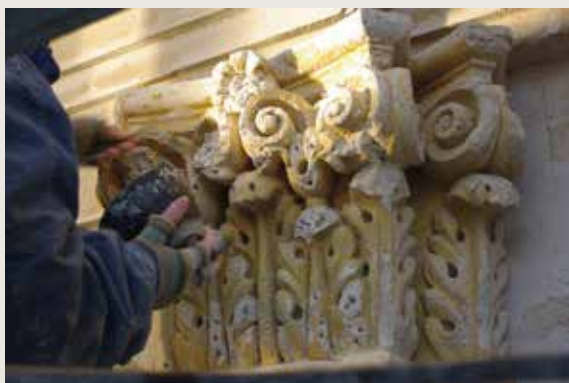
De Duive. Reparatie van twee kapitelen, detail. Niet geïdentificeerde steen (© CHE, 2012).
