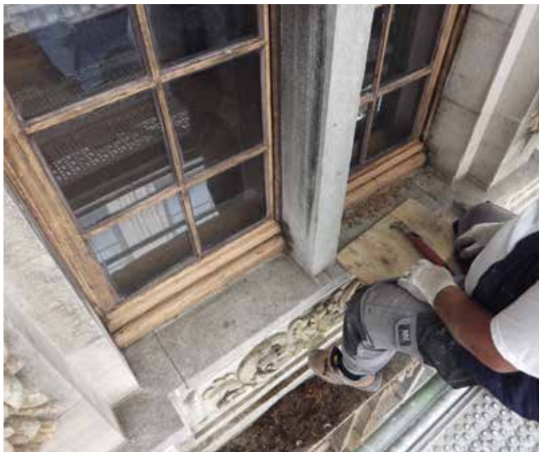
Den Cruywagen. Manuele decapering van het schrijnwerk. Eik (© CHE, 2014).
