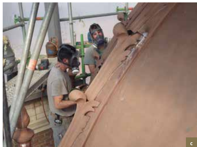
Den Coninck Van Spaignien . Verschillende stappen van de restauratie van de koperen koepel. a) toestand voor de restauratie, met vervuiling en groene patina; b en c) alle koperen elementen worden gezandstraald om het koper bloot te leggen en te restaureren, dat wil zeggen dat beschadigde stukken werden vervangen en beschadigd laswerk werd hersteld; d) reinigen en polijsten met staalwol (© CHE, 2015).
