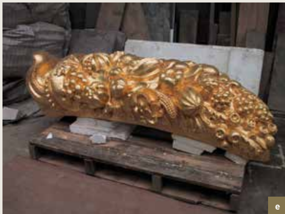
Den Ezel. De verschillende stappen voor de vervanging van de hoorns des overvloeds van de geveltop. a) toestand van de Euvillesteen voor demontage; b) de erg beschadigde hoorns des overvloeds worden op basis van oude foto's in het atelier met gips gerepareerd. Deze stukken fungeren als model voor de nieuwe elementen; c) met behulp van een driepuntpasser wordt het model gekopieerd in Euvillesteen ; d) een van de afgewerkte nieuwe elementen; e) een van de beelden verguld met bladgoud; f) eens ze afgewerkt zijn, worden de hoorns des overvloeds met een kraan naar boven gehesen en zorgvuldig gemonteerd. (© CHE, 2003-2004).
