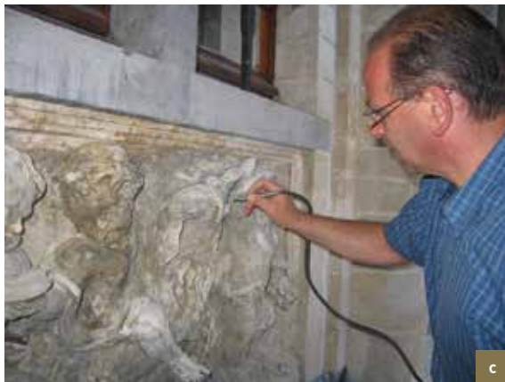
Het Brouwershuis. Details van een van de panelen op de borstwering van de tweede verdieping met een voorstelling van de wijnoogst (Pierre Van Dievoet, 1698). Waarschijnlijk in Avendersteen. a) verontreinigde putti-sculpturen voor de restauratie, met links gedeeltelijke reiniging; b) applicatie van kompressen met cellulosepasta op basis van ammoniak, om de zwarte korsten zacht te maken; c) verfijning van de reiniging met een micro-zandstraalapparaat; d) toestand na reiniging (© CHE, 2004).
