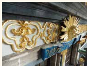
De Vos. Detail van de zon met stralenkrans. Ornament in gehamerd roodkoper. a) voor reiniging; b) verguld element in het atelier; c) het gerestaureerde geheel (© CHE, 2014-2015).
