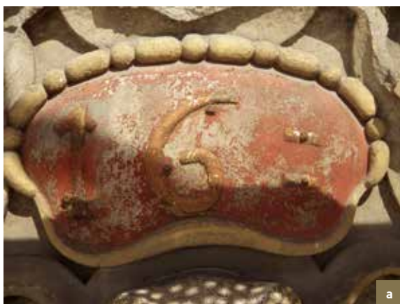
Den Cruywagen. Detail van de medaillons met jaartal. a) medaillon links voor restauratie; b) medaillon rechts na restauratie (reparatie van de stenen, aanbrengen van de kleuren en het verguldset) (© CHE, 2014-2015).
