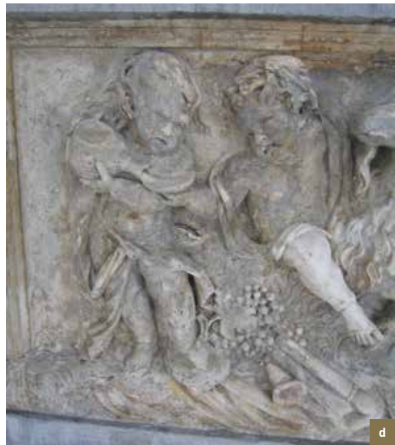
Het Brouwershuis. Details van een van de panelen op de borstwering van de tweede verdieping met een voorstelling van de wijnoogst (Pierre Van Dievoet, 1698). Waarschijnlijk in Avendersteen. a) verontreinigde putti-sculpturen voor de restauratie, met links gedeeltelijke reiniging; b) applicatie van kompressen met cellulosepasta op basis van ammoniak, om de zwarte korsten zacht te maken; c) verfijning van de reiniging met een micro-zandstraalapparaat; d) toestand na reiniging (© CHE, 2004).
