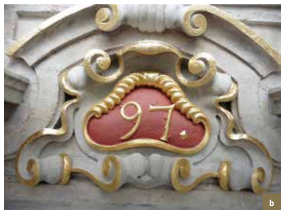
Den Cruywagen. Detail van de medaillons met jaartal. a) medaillon links voor restauratie; b) medaillon rechts na restauratie (reparatie van de stenen, aanbrengen van de kleuren en het verguldset) (© CHE, 2014-2015).
