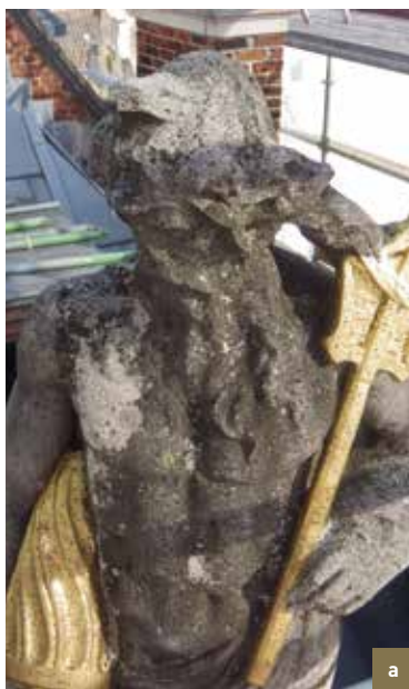
Den Coninck Van Spaignien . Sculptuur Het Water – Neptunus (Isidore De Rudder, 1898) op de balustrade, voor (a) en na reiniging (b). Euvillesteen (© CHE, 2014).
