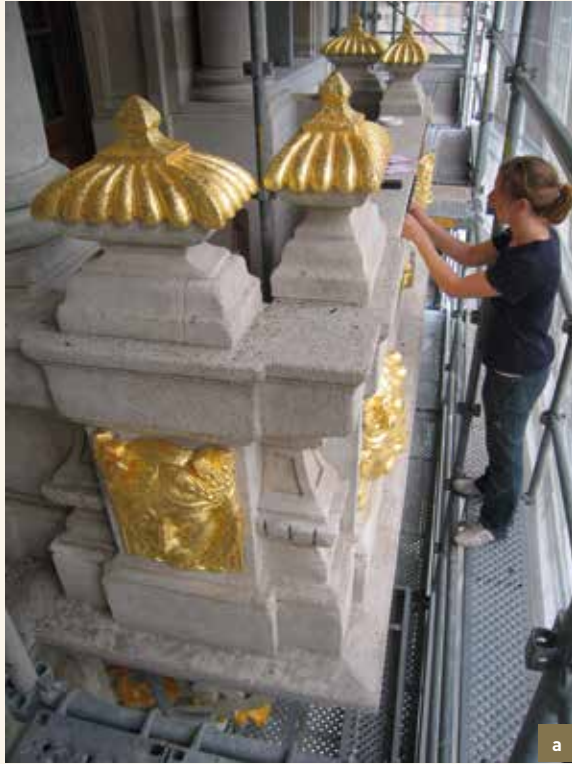
De Swane . a en b) de mascarons van het balkon (Venneman, 1903) tijdens het vergulden. Euville (© CHE, 2008).
