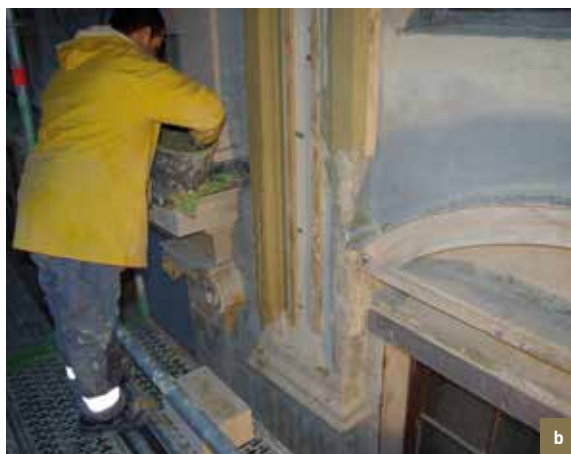
De Gulden Boot . a en b) het aanbrengen van bepleistering op een kolossale pilaster (© CHE, 2012).
