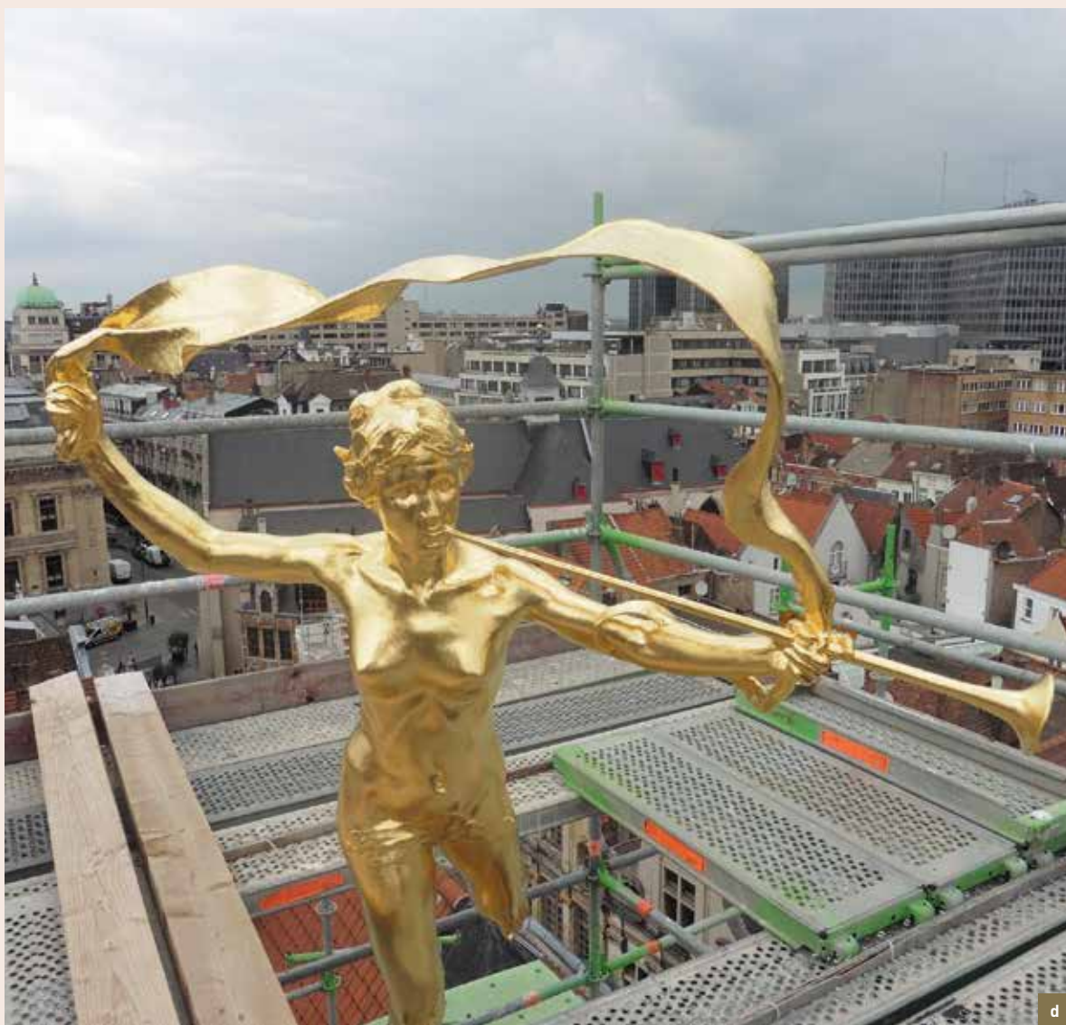
Den Coninck Van Spaignien. Verschillende stappen van de restauratie van het bronzen beeld De Faam (of Het Fortuin , Paul Du Bois, 1902). a) De Faam na restauratie; b) detail van de kop van het beeld voor restauratie; c) het beeld wordt geschilderd (voorbereidende laag voor het vergulden); d) verguld beeld (© CHE, 2014-2015).
