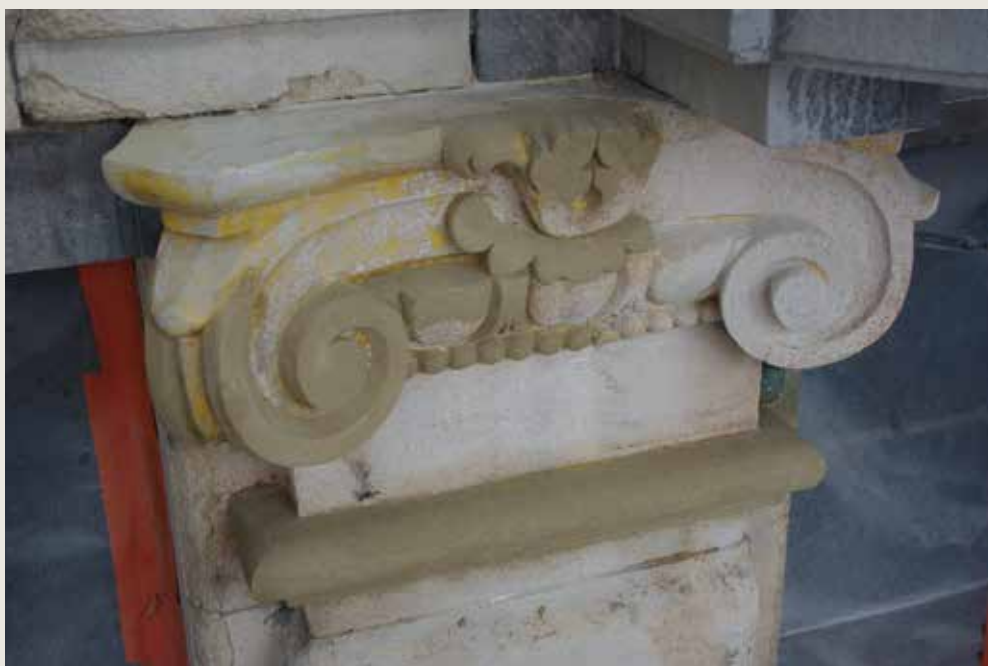
Den Engel. Restauratie van een kapiteel. Euvillesteen (© CHE, 2012).
