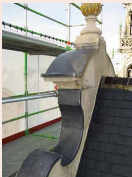
De Wapens van Brabant. Herstelde loodbedekking op de plaatsen blootgesteld aan regenwater (© CHE, 2008).
