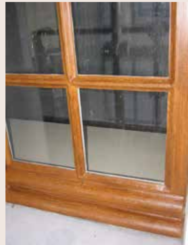
De Swane. Sommige ramen die niet van eik waren, hadden een imitatiebeschildering van eik (© CHE, 2008).
