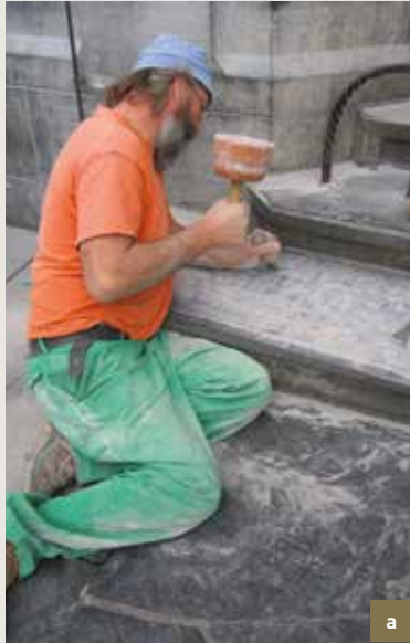
De Swane. a) het ciseleren van de toegangstrap op basis van bestaand model. Arduin; b) voltooid werk (© CHE, 2008).
