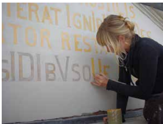
De Gulden Boot. Detail van het jaerdicht op het timpaan van het fronton. Het aanbrengen van een grondlaag op de letters, ter voorbereiding van het vergulden (© CHE, 2012).
