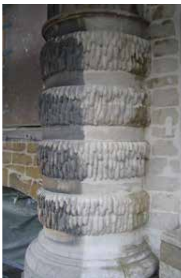
Brouwershuis . Reinigingsproef. Detail van de rustieke bossage van de zuilen. Balegemse steen. Reiniging met een roterende hydropneumatische lichtedrukstraal (© CHE, 2004).
