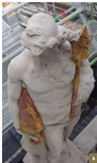
Den Coninck Van Spaignien . Sculptuur Het Water – Neptunus (Isidore De Rudder, 1898) op de balustrade, voor (a) en na reiniging (b). Euvillesteen (© CHE, 2014).
