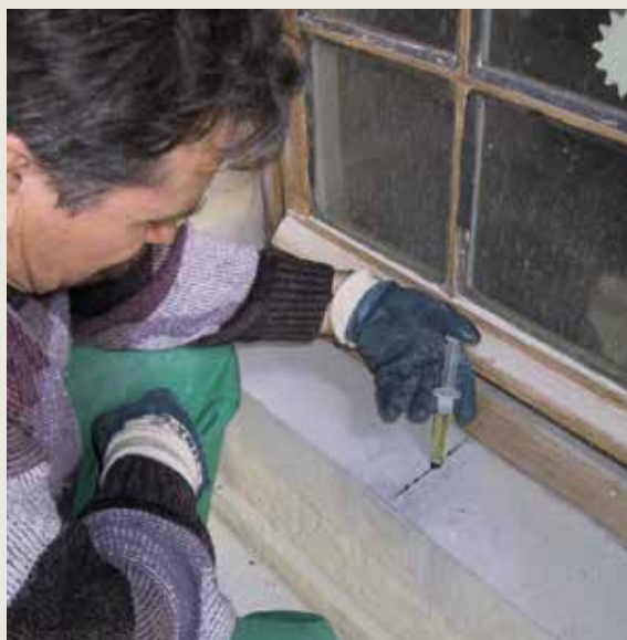
Den Ezel . Dorpel in hardsteen. Injectie van het product (twee componenten epoxy) in de speciaal hiervoor gemaakte kleine gaatjes (© CHE, 2003-2004).
