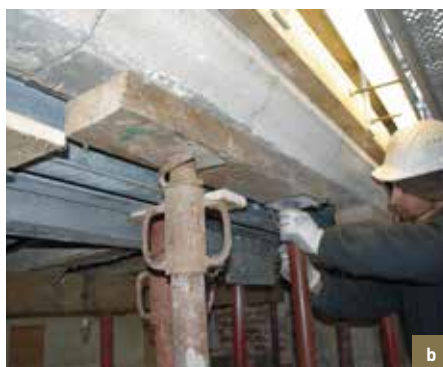
De Heert. a) het schoren van metselwerk in Euvillesteen en plaatsing van een metalen beugel met het oog op de demontage van de gecorrodeerde metalen balken; b) plaatsing van nieuwe balken in gegalvaniseerd staal (© CHE, 2008).
