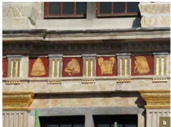
De Wolvin. Detail van de metopen met vergulde motieven op de fries die verwijzen naar het boogschieten. a) restauratietest op het rechtergedeelte; b) het uiteindelijke resultaat (© CHE, 2014-2015).
