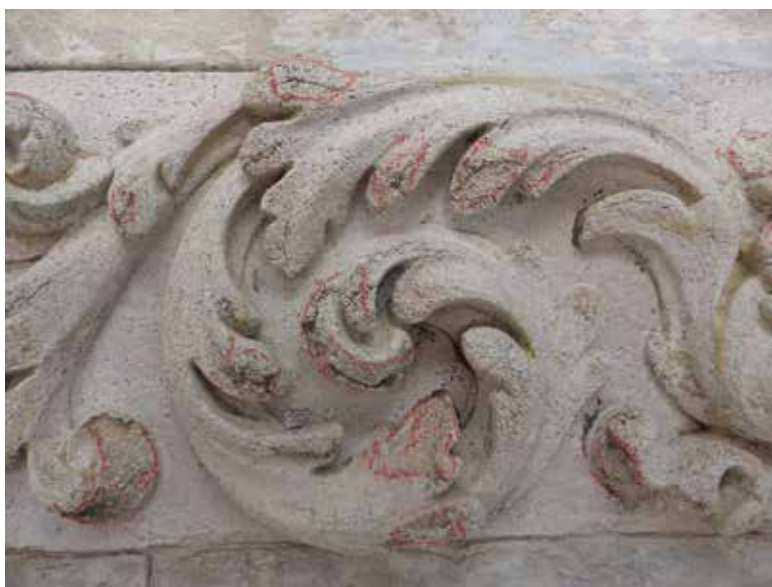
Den Cruywagen. Detail van een rankmotief waarop de gedeelten die met herstellingsmortel moeten gerepareerd worden, met rood krijt gemarkeerd zijn. Euvillesteen (© CHE, 2014).
