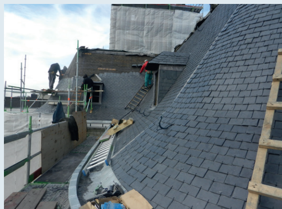
Afb. 1 Restauratie van het dak en het gebinte (© CHESB 2013).
