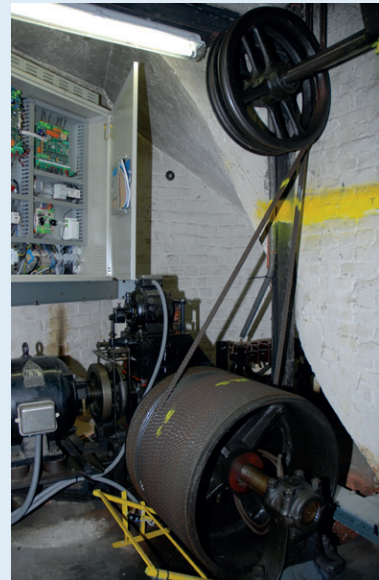
Installatie van een nieuwe schakelkast in een gebouw aan de Bosstraat in Brussel (© Jérôme Bertrand).
