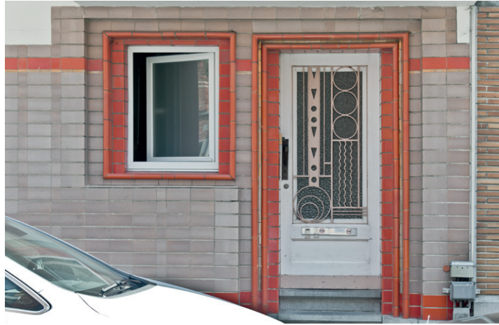
Afb. 6 Gevel van het gebouw op de hoek van de Charles Leemansstraat en de Kerkstraat Sint-Agatha-Berchem [A de Ville de Goyet, 2015 © GOB].
