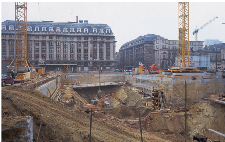
Afb. 17 Het Poelaertplein midden de jaren 1990. Werken voor de bouw van de ondergrondse parking (© GOB).
