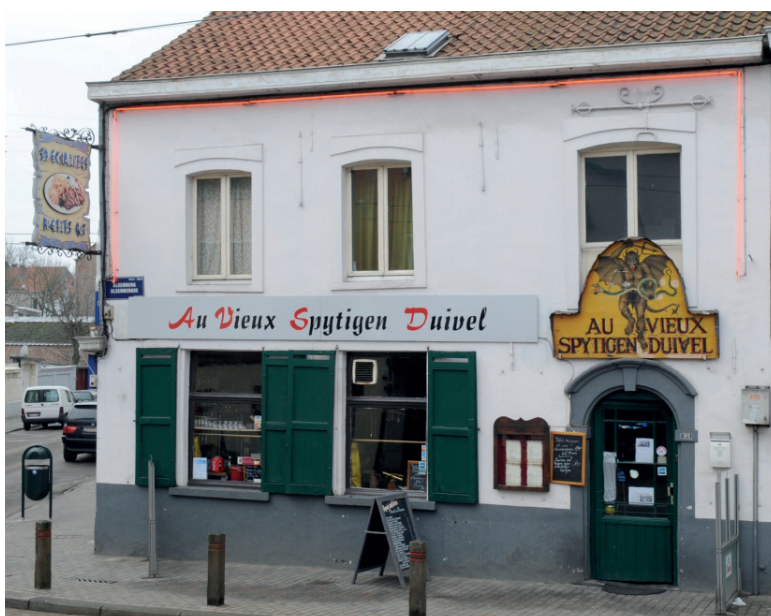
Afb. 1 De Vieux Spijtigen Duivel in Ukkel. Actuele toestand (M. Vanhulst, 2012 © GOB).
