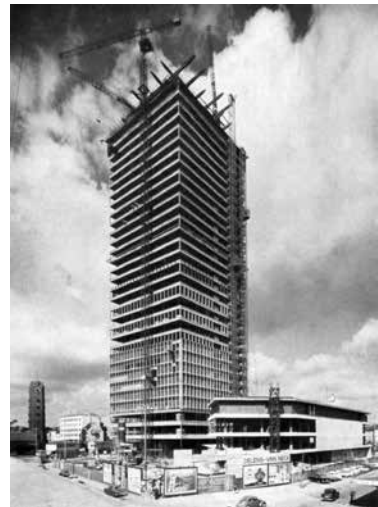
De zuidertoren in opbouw ( La Technique des Travaux , vol. 42, nr. 11-12, 1966, p. 335).
