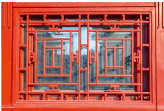
Afb. 3b Oud Chinees venster met claustra, Verboden Stad, Peking, China (© foto Aphotostory/Shutterstock.com).
