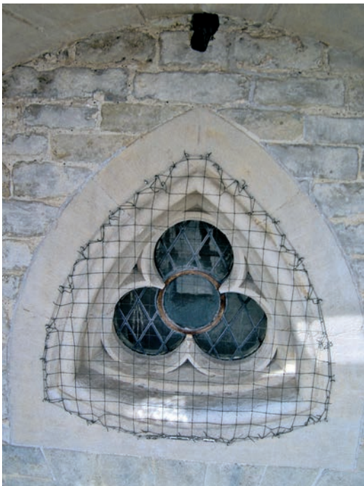
Afb. 19 Antiduvennet voor de oculus bovenaan in de westgevel (B. Beaume, 2008 © Regie der Gebouwen).
