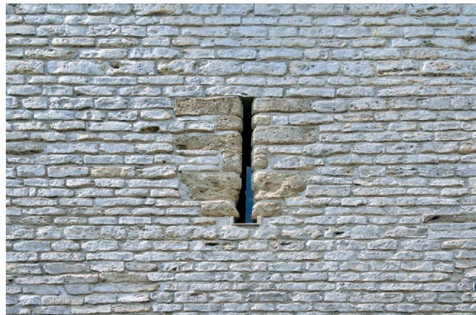
Afb. 20 Het parement in Gobertangesteen, gereinigd en opnieuw gevoegd, klaar voor de vochtwerende behandeling (B. Beaume, 2008 © Regie der Gebouwen).
