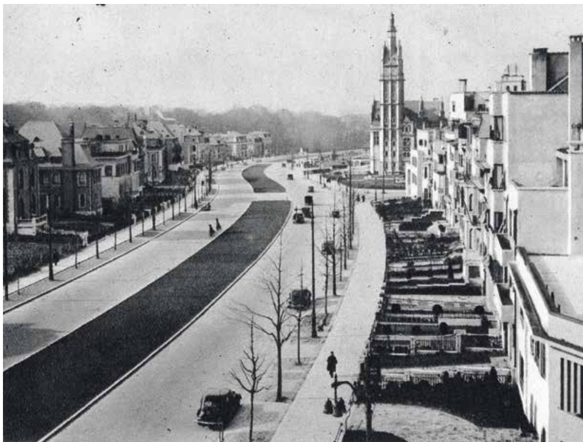
Afb. 8 Natiënlaan (thans Franklin Rooseveltlaan) [ Bâtir 1938, nr. 63, p. 70].
