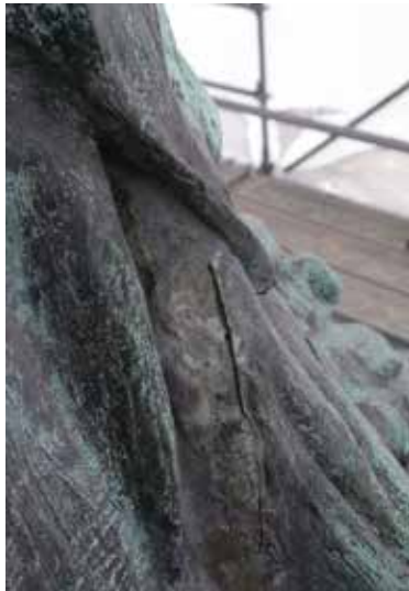
Afb. 3 Openstaande barst met insijpeling tot gevolg (© Metafose).
