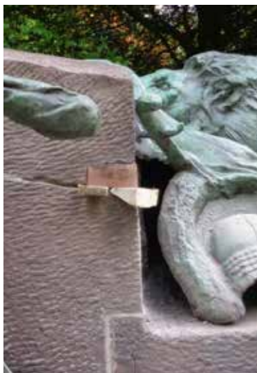
Afb. 5a Herstelling sarcofaag met behulp van inboetstuk in uitvoering (gebruik makend van deel gebroken padsteen) (© AVAPartners).
