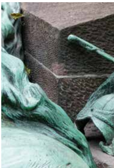
Afb. 5b Herstelling sarcofaag na afwerking met identieke eindbekapping (© AVAPartners).
