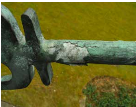
Afb. 11b Afladeren van de koperlaag op de aluminium drietand (© Metafose).
