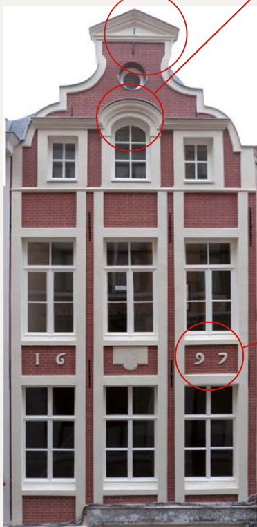
De verdiepingen op nr. 53 Spoormakersstraat, na de restauratie © iD.Cité.Architects)
