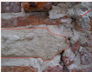
De lijst aan de voet van de geveltop was afgesleten maar het profiel aan het einde was leesbaar gebleven (S. Modrie © GOB-ULB).
