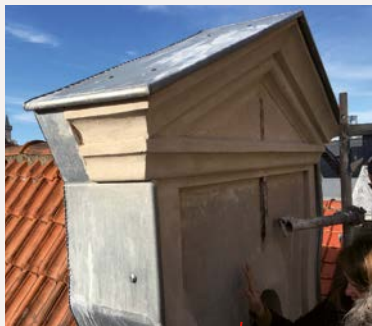
Het in kalkmortel gerestaureerde fronton © iD.Cité.Architects).
