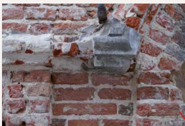
Rijen uitspringende bakstenen die de aanzet vormen van de lijst van de geveltop (S. Modrie © GOB-ULB).
