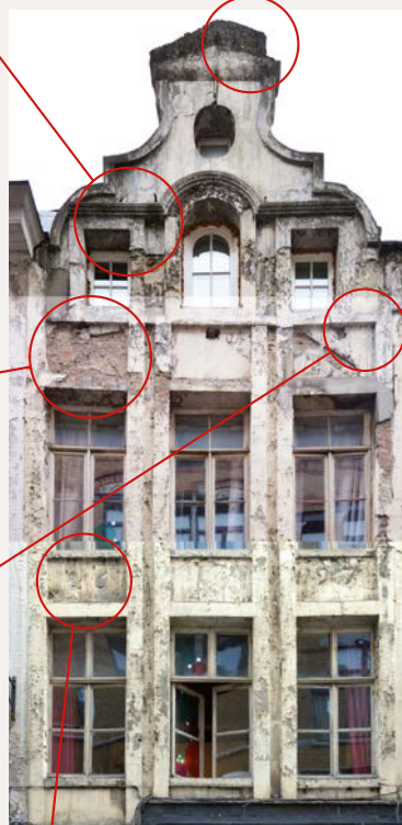
De verdiepingen op nr. 53 Spoomakersstraat, voor de restauratie (© O. Berckmans)
