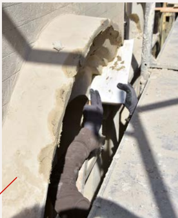
Uitvoering van de lijsten in kalkmortel, met behulp van een mal, rechtstreeks op de bewaarde stenen of bakstenen elementen van het oorspronkelijke lijstwerk (Ph. Sosnowska © G0B-ULB).
