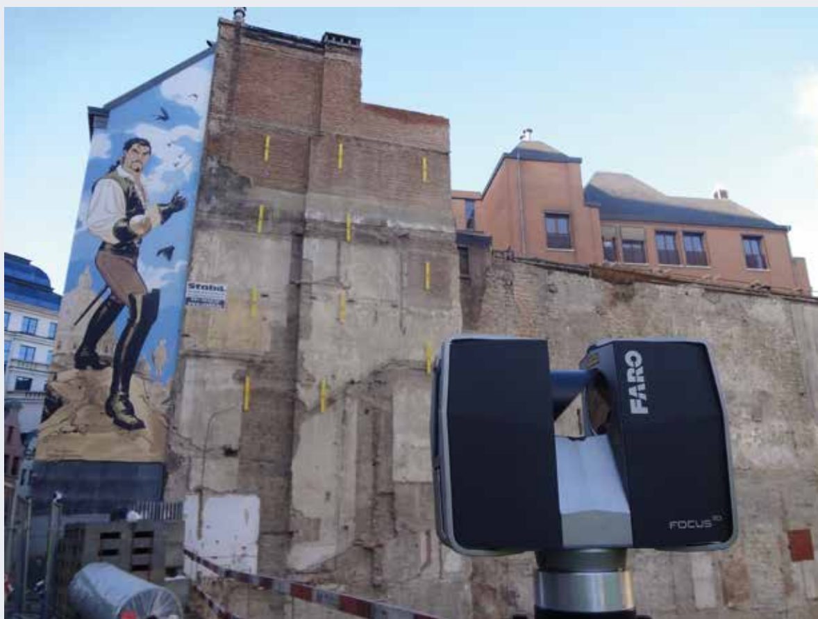
3D-scan tijdens de restauratie van een deel van de 13e-eeuwse stadsomwalling gelegen aan de Treurenberg te Brussel (C. Devillers, 2014 © BUP/BSE).
