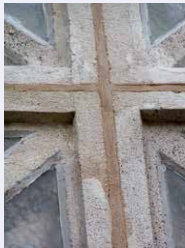
Afb. 14 Verse patch repair die met de truweel werd aangebracht op de claustra's van de Sint-Jan-de-Doperkerk. Het kleurverschil verdwijnt binnen de 3 maanden [G. Stegen, 2007 © ARSIS].
