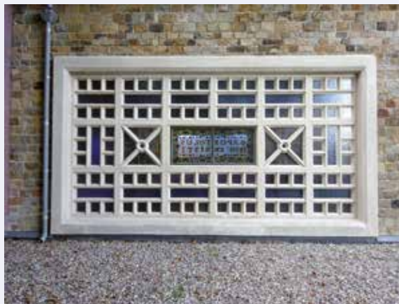
Afb. 16 Gerestaureerde claustra waarin een buitenbeglazing geplaatst werd en het gerestaureerde glasraam aan de binnenzijde werd teruggeplaatst [G. Stegen, 2019 © ARSIS].
