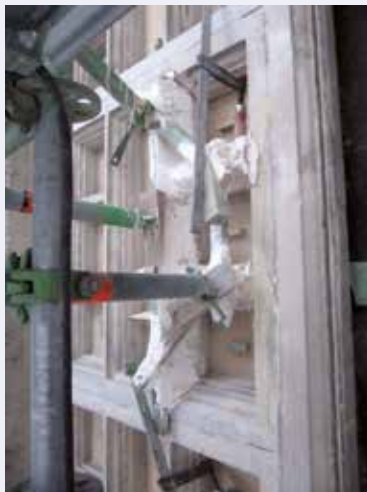
Afb. 13 Een bekiste en gegoten patch op een van de claustra's van de Sint-Suzannakerk [G. Stegen, 2015 © ARSIS].
