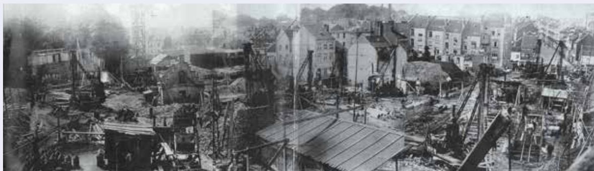
Werk van het Résidence Palace, Wetstraat, Brussel, gefotografeerd in 1923. Hier werden 2.458 Franki-pijlers van 6 tot 12 meter diepte gebruikt. Zilvergelatinedruk, 16 x 55 cm (© CIDEP).
