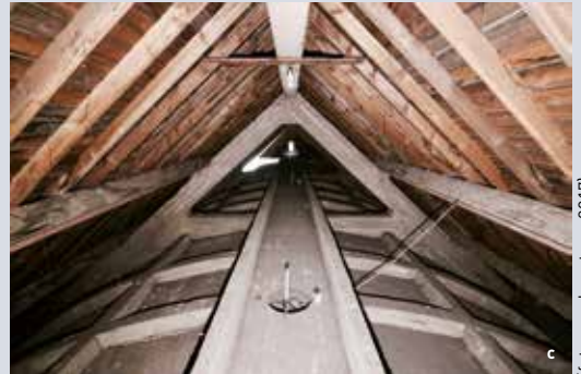
Afb. 6a tot 6c: Sint-Lambertuskerk, Sint-Lambrechts-Woluwe : a) Voorgevel; b) Brede middenbeuk; c) Dakgebinte in gewapend beton
