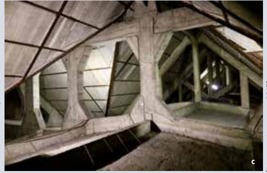
Afb. 1a tot 1c: Sint-Pieter-en-Pauluskerk, Neder-Over-Heembeek : a) Voorgevel; b) Schip; c) Dakgebinte in gewapend beton
