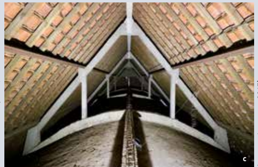
Afb. 3tot tot 3c: Sint-Aleidiskerk, Sint-Pieters-Woluwe : a) Voorgevel; b) Schip; c) Dakgebinte in gewapend beton
