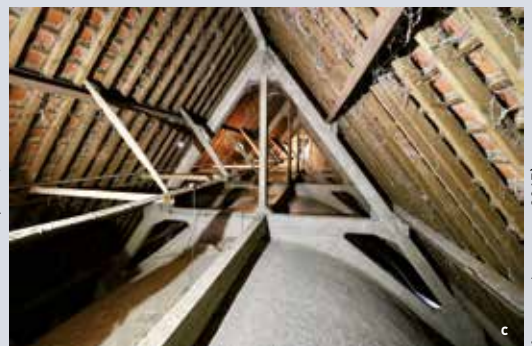
Afb. 4a tot 4c: Kerk van de Goddelijke Verlosser, Schaarbeek : a) Voorgevel; b) Schip; c) Dakgebinte in gewapend beton
