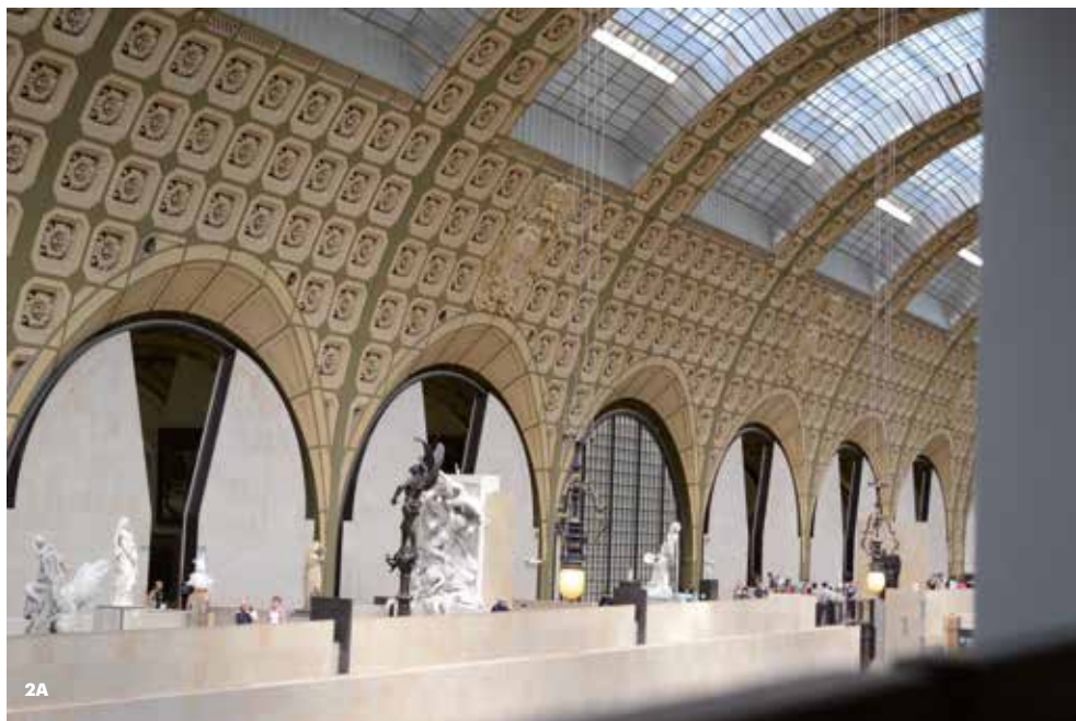
AFB. 2A EN 2B In de gewelven van het voormalige Orsay-station in Parijs dat tot museum werd herbestemd werd 40 000 akoestische resonatoren verwerkt (afb.2a © ( https://sites.google.com/site/lartmoderneenfranceetenespagne/le-musee-d-orsa ); afb.2b : foto Gilmanshin, 2017 © Depositphotos).
