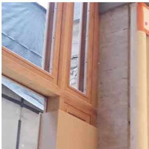
AFB. 11 Nieuw raamkader in een van de audientiezalen van het Brusselse Justitiepaleis (foto van de auteur).
