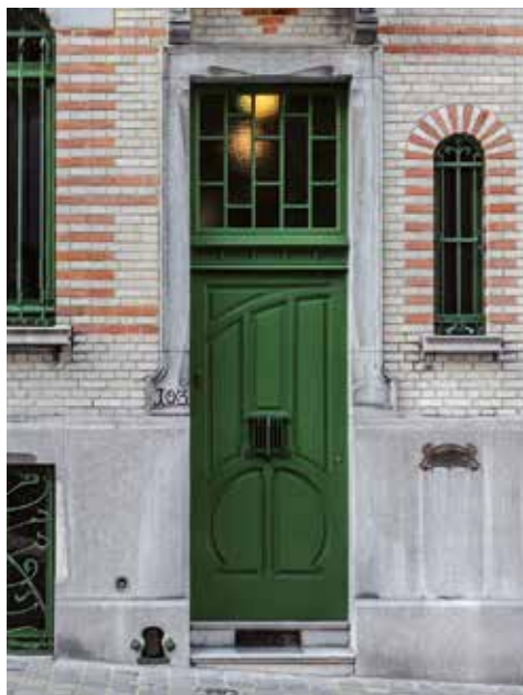
AFB. 10 Brievenbussen die in de gevel ingewerkt zijn laten het geluid door. Gevel van het atelier Rogiers, Keizer Karelstraat, 103 te Brussel (A. de Ville de Goyet © urban.brussels).
