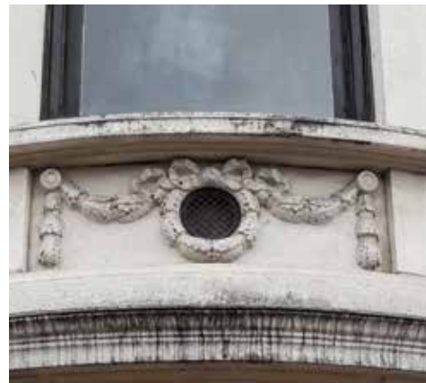
AFB. 9 Ventilatioerooster in een eclectische woning, Tervurenlaan, 48 te Etterbeek (foto van de auteur).
