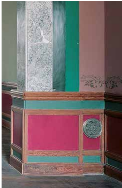
AFB. 8 Rooster in een wand van de woning Autrique te Schaarbeek (foto van de auteur).
