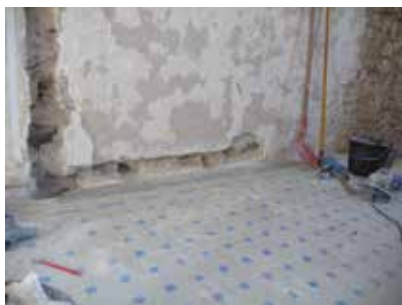
AFB. 13 Sleuven die de muur verzwakken (© Au Moulin de Bas).
