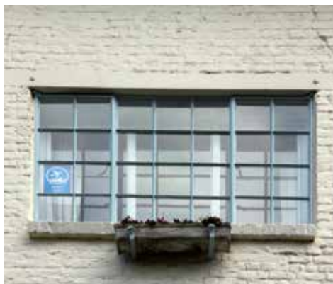
AFB. 12 Plaatsing van een nieuw raam aan de binnenzijde, Schermlaan, 41 te Sint-Pieters-Woluwe (foto van de auteur).
