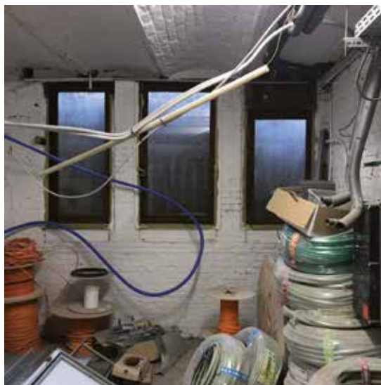
AFB. 8 Origineel raam aan de straatgevel, bovenaan voorzien van een rooster (niet meer aanwezig), waarbinnen verse lucht werd binnengebracht langs een zinken kanaal aan het plafond (nr. 1 op afb. 7) (© B. Van der Wee Architects, 2019).
