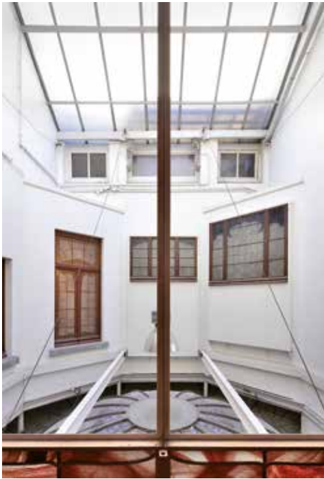
AFB. 14 Lichtschacht boven de centrale koepel in loodglas waarin nog twee originele houten pivoterende raampjes aanwezig zijn (foto Filip Dujardin, 2019).
