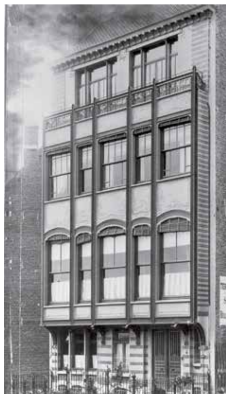
AFB. 2B Straatgevel van de oorspronkelijke woning in staalstructuur, 1897 (© Hortamuseum).
