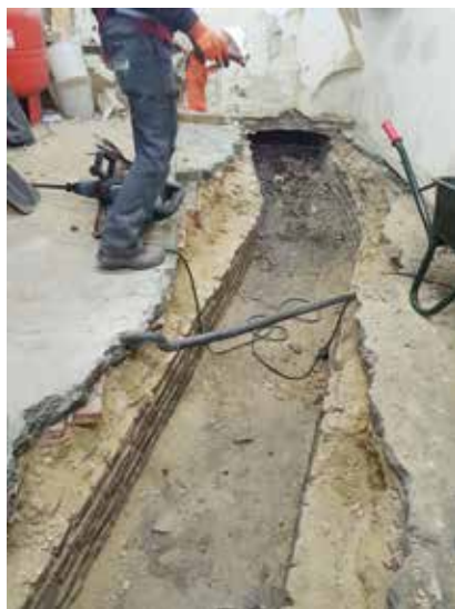
AFB. 7 Origineel raam aan de tuinkant waarachter een keldergat de verse lucht binnenbracht via een ondergronds kanaal in metselwerk, dat tijdens de werf in 2019 werd teruggevonden en gerestaureerd (nr. 4 op afb. 7) (© B. Van der Wee Architects, 2019).
