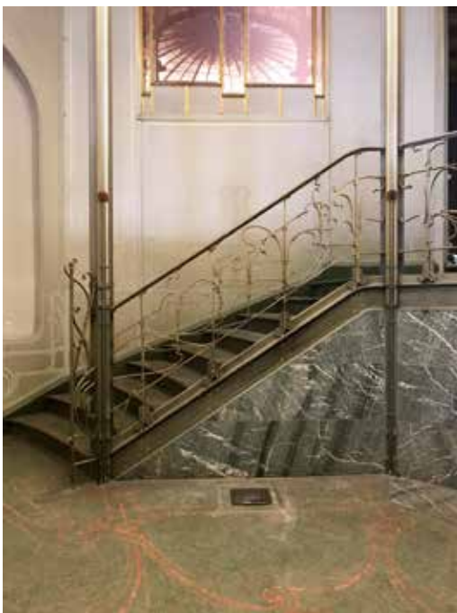
AFB. 11 De wintertuin: in de vloer van de achthoekige ruimte waar de trap vertrekt naar de rondgang situeert zich het afsluitbaar ventilatie rooster waarlangs de verse lucht vanuit de kelder wordt binnengebracht. (nr. 4 in afb. 9) (© B. Van der Wee Architects, 2020).
