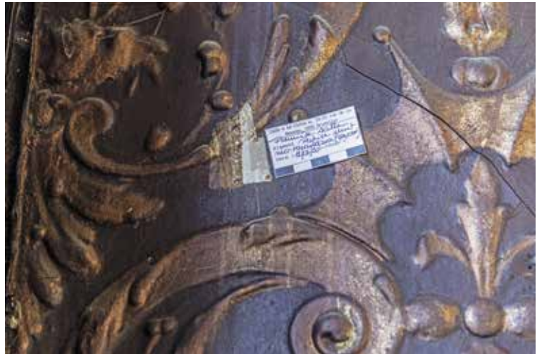
AFB. 11 Stratigrafie van het behangpapier van de eerste zaal. (A. de Ville de Goyet, 2020 © urban.brussels)
