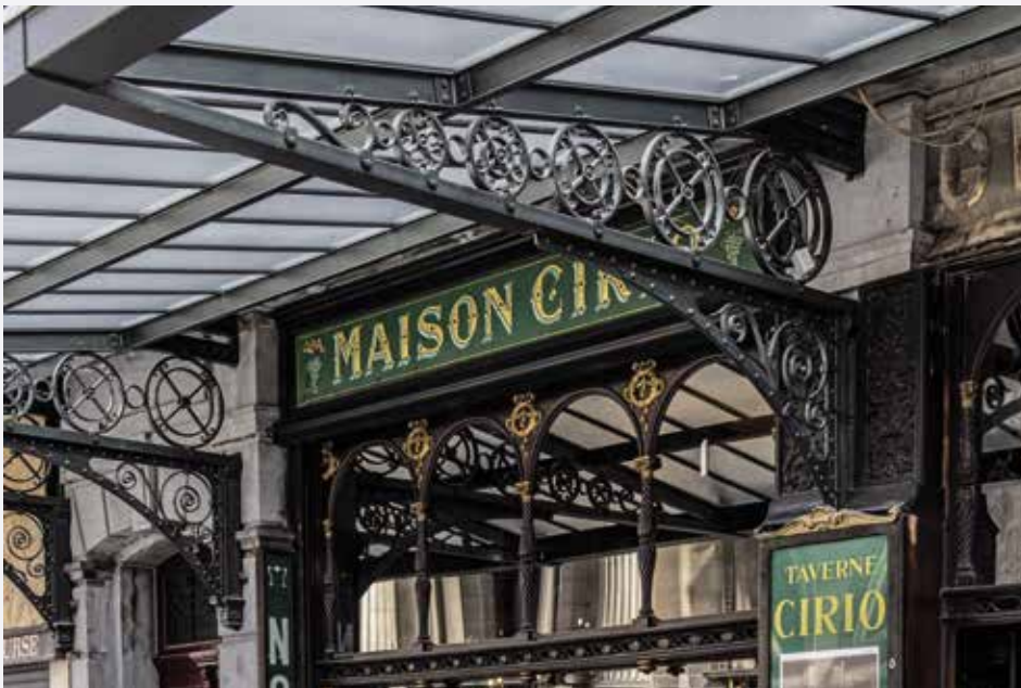
Luifel na de restauratie. (A. de Ville de Goyet, 2020 © urban.brussels)
