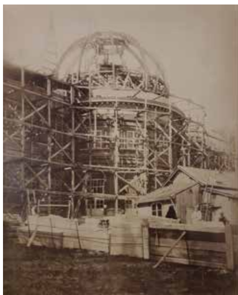
AFB. 9 Reconstructie van de koepel van het kasteel van Laken na de brand in 1891 (10 maart 1892) (© AKP).
