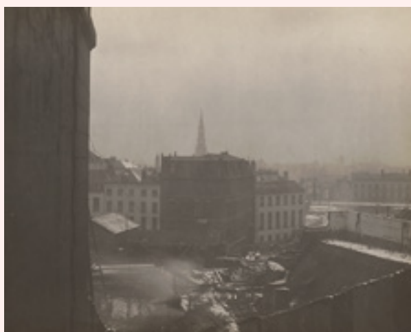
AFB. 4B Volgens de aanduidingen op de achterzijde van de foto: beeld genomen onder aan het bovenste trapdeel, vóór de transformatie ervan (© SAB, Papieren Charles Buls, 19b).
