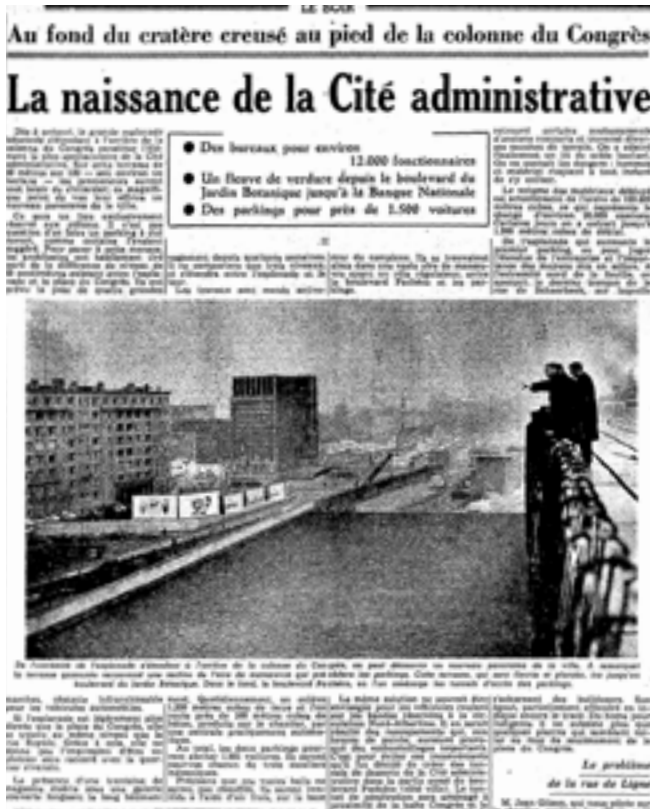
AFB. 13 De esplanade van het RAC, tijdens de bouw ervan, uittreksel uit de krant Le Soir van 8 januari 1961 (© KBR).
