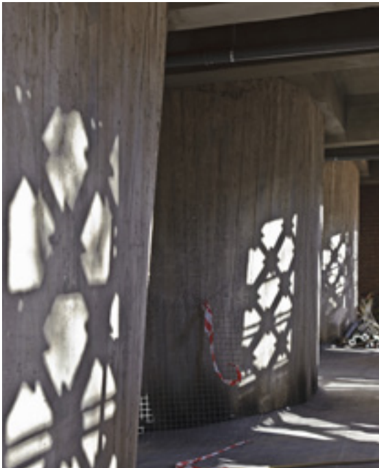
AFB. 1 Congreshalte. De indrukwekkende betonnen verluchtingskokers verborgen door de claustra's (A. de Ville de Goyet, 2016 © urban.brussels).
