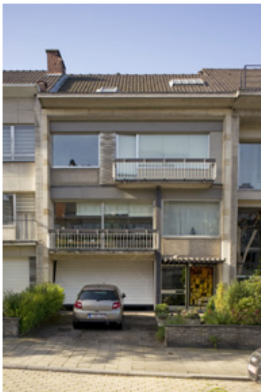
AFB. 39 Woning Lichtert, Villagaslaan nr. 29 in Ganshoren, arch. Raoul J. Brunswyck en Odon Whatelet, 1963 (A. de Ville de Goyet, 2012 © urban.brussels).
