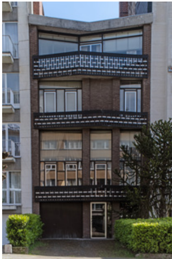
AFB. 47 Woning Rombaut -Deplus, Armand Huysmanslaan nr. 196 in Elsene, arch. André Jacqmain, 1959 (A. de Ville de Goyet, 2024 © urban.brussels).
