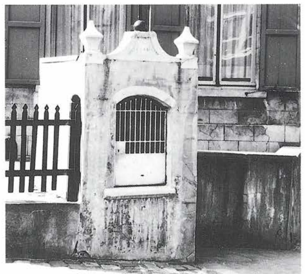
16. De kleine Sint-Agatha kapel op het Kerkplein in 1969, vóór de restauratie (foto, verzameling R. VERBEKE / Graafschap Jette).
