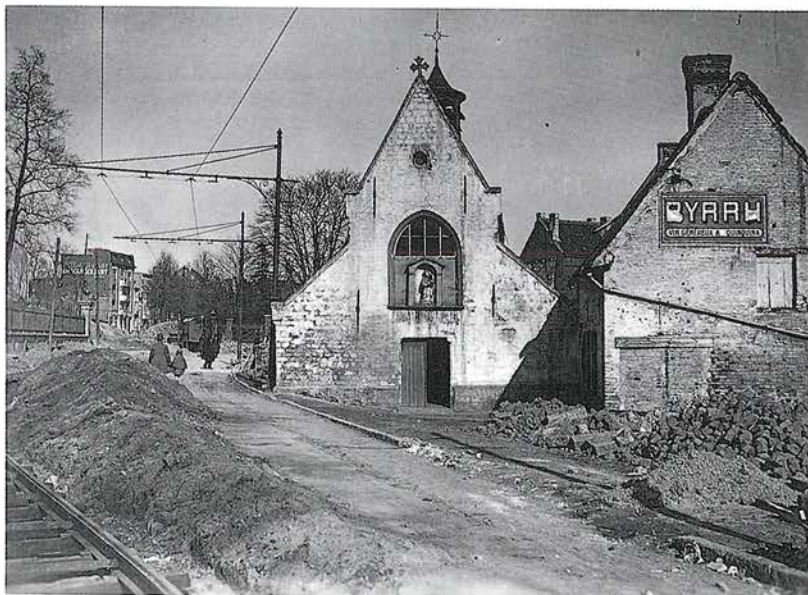
62.Zicht op de werken van de tramrails rond de kapel van Stalle in het begin van de 20 ste eeuw (foto, © A.C.L. Brussel).
