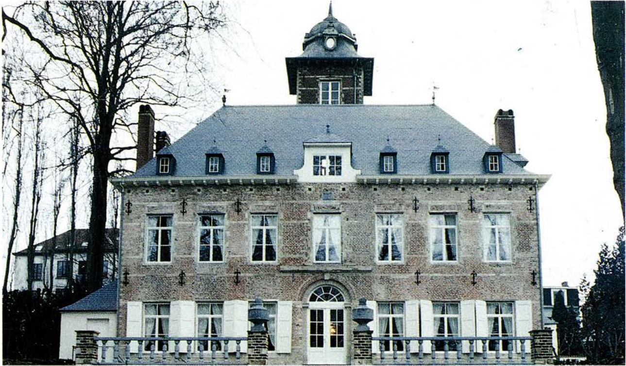
92.Zicht op de gevel van het Papenkasteel (foto Y. CABUY, 1992).
