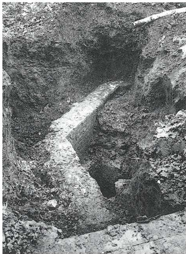
75. Funderingen van de kapel van Calevoet , aan het licht gebracht in 1943 (foto Nationale Dienst voor Opgravingen, © A.C.L. Brussel).
