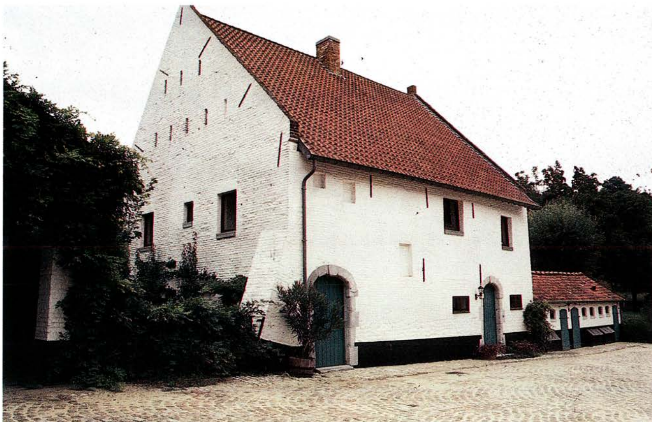
77. Zicht op de gerestaureerde schuur van de Sint-Elooihoeve (foto Y. CABUY, 1992).
