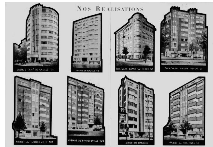
Overzicht van Etrimo gebouwen, 1938.
