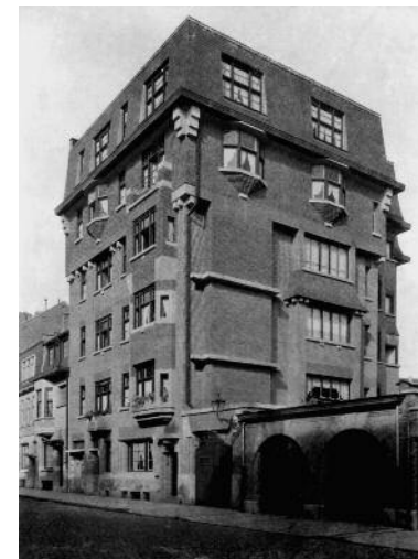
André Darche, Louis Hymansstraat 9, Elsene 1928. Dit gebouw kent een grote variëteit in vorm en materiaal. Het materiaalgebruik met de baksteen in verschillende baksteenverbanden zijn te herleiden tot de Amsterdamse School architectuur, terwijl de afwerking van het interieur meer trekken van de art deco vertoont en de geometrische vormen aansluiten bij het kubisme.
