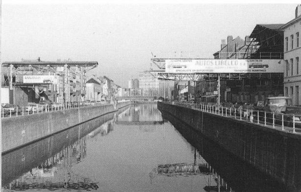
De laadportalen voor bouw materiaal van de voormalige opslagplaats Cigrasa.
