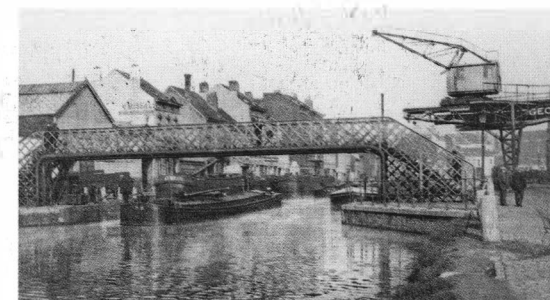
De oude voetgangersbrug van de Gosseliesstraat, opgetrokken in opdracht van de Molenbeekse werkgevers opdat hun arbeiders gemakkelijker beide oevers konden bereiken. Deze metalen loopbrug is vervangen door het huidige, betonnen exemplaar.
