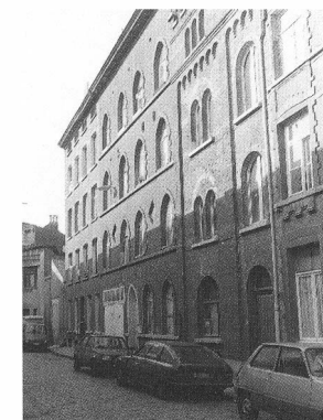
Huurpanden in de Darimonstraat. De uitbreidingen van de Minoterie Farcy die de impasse afsloten, werden afgebroken.
