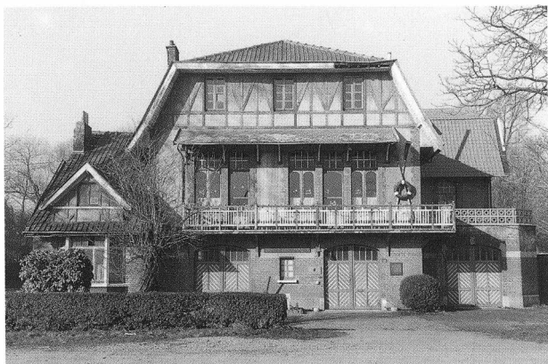
Een paviljoen met botenhuizen, opgetrokken in 1910 door de Union Nautique de Bruxelles . Het gebouw bestaat nog steeds en bevindt zich tussen de installaties van het bedrijf Solvay en het terrein van de Cokeries du Marly .
