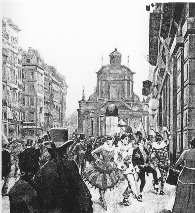
De nieuwe centrale lanen ontloopten zich snel tot het centrum bij uitstek van ontspanning en vermaak. Op vastenavond liep het volk er steevast te hoop om carnaval te vieren. Het was een jaarlijks hoogtepunt in het leven van arbeiders en dienstmeisjes, die er voor enkele uren de sleur van het dagelijks bestaan kwamen ontvluchten.
