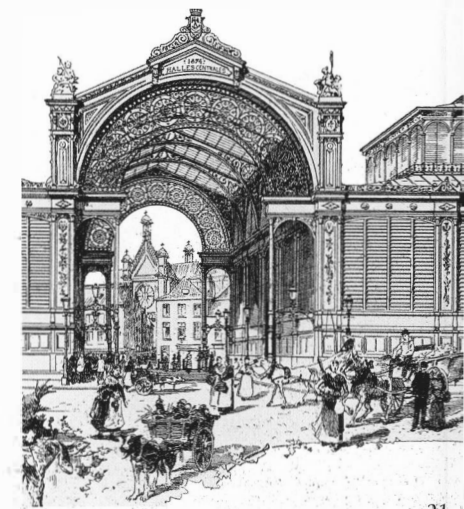
Centrale overkapping van de Centrale Hallen in het verlengde van de Grétrystraat, getekend door L. Titz. Deze overdekte markt, gebouwd naar de plannen van L. Suys en E. Legraive, was een prachtig voorbeeld van 19de-eeuwse metaalarchitectuur.
