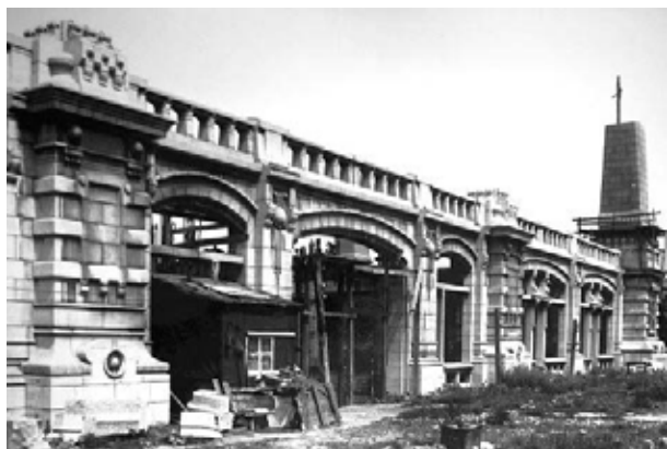
Bouw van de bogen van het viaduct van de Noord-Zuidverbinding.
