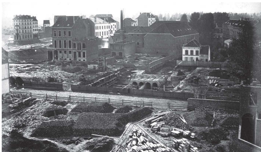
Zicht op de werf van de overwelving van de Zenne, aan de kruising van de huidige Zuid- en Lemonnierlaan. Foto toegeschreven aan J. Kampfe, 1870.
