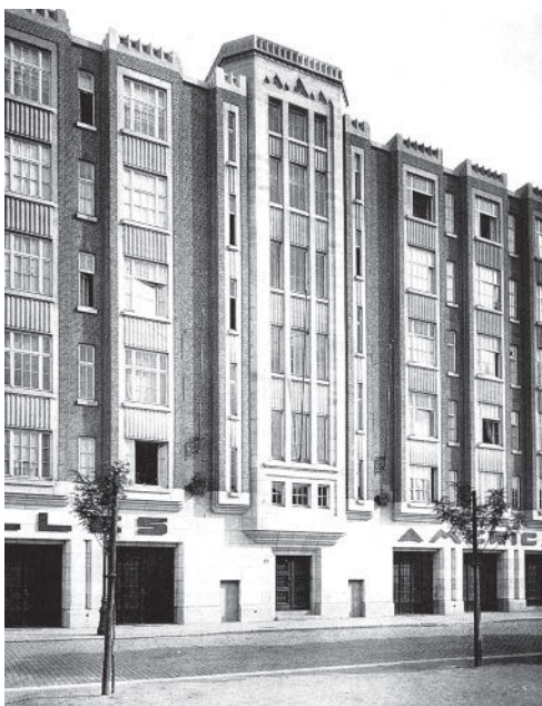
Halles America, ontworpen door F. Petit. Foto uit 1922.
