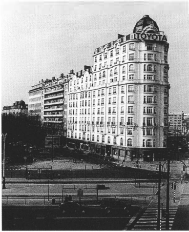
«LE SAILLANT DE L'YSER» Dit luxueuze appartementsgebouw van elf verdiepingen aan de Diksmuidelaan nrs 32-40 en het Ijzerplein nr 6 is ontworpen door de Parijse architecten L. Duhayon en M. Julien, in opdracht van de «Société Immobilière de Belgique». Het werd in drie fases gebouwd tussen 1925 en 1930. Het uitspringende hoekgedeelte met de koepel, dat versierd is met Art Déco-motieven, is door zijn machtig silhouet een visueel baken op de brede lanen die werden aangelegd ter gelegenheid van de Wereldtentoonstelling van 1935. «Le Saillant de l'Yser» is een representatief voorbeeld van het urbanistische en architecturale denken uit het Interbellum.
