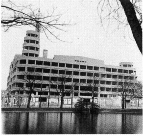
Het N.I.R.-gebouw in opbouw, omstreeks 1937.
