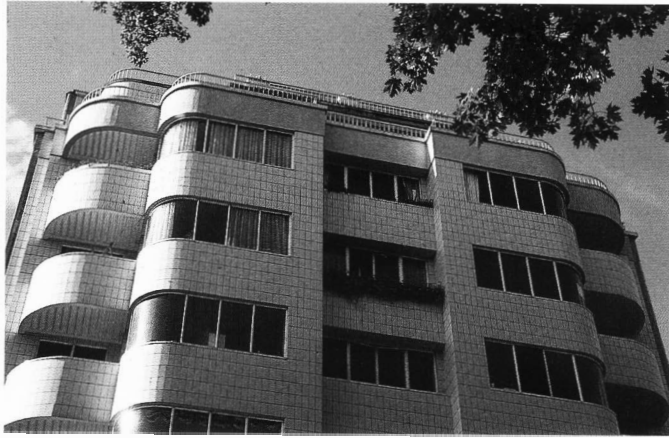
"La Cascade", Generaal de Gaullelaan 36. Architect R. Ajoux.
