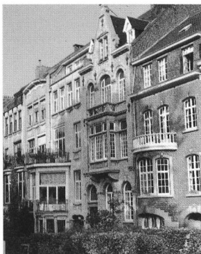
Huizenrij in de Klauwaartslaan die een mengeling toont zien van verschillende bouwstijlen uit het begin van deze eeuw. neo-Vlaamse renaissance van Pierre De Groef op nr 31, Beaux-Arts-stijl bij nrs 12-13.
