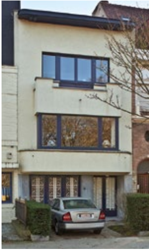
Woning, Jupiterlaan 15. Arch. Henri Leborgne (foto A. de Ville de Goyet © GOB)
