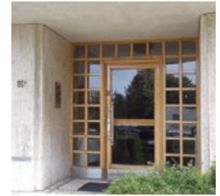
Ingang van het appartementsgebouw Duden Horizon, Jupiterlaan 91 A. Arch. Roger Dejenefte en Joseph Thomas, 1952. (foto van de auteur)
