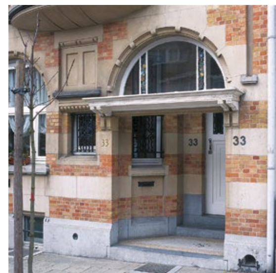
Geveldetail, V. Rousseaulaan 33. Arch. François Van Meulecom, 1923. (foto P. De Gobert © AAM)
