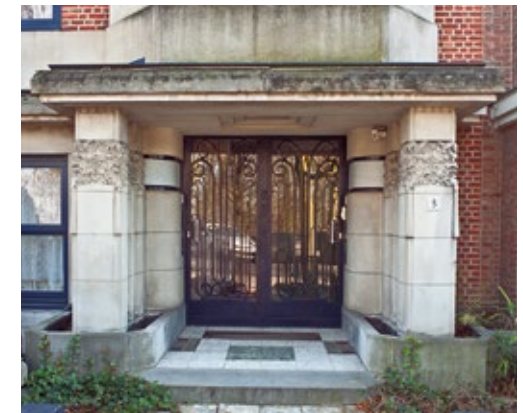
Detail van het portiek van de eigen woning van architect Willem Vermeiren, 1934. (foto A. de Ville de Goyet © GOB)
