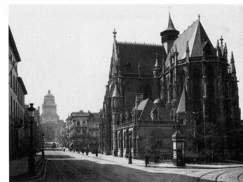
Het gerestaureerde koor, de afgewerkte sacristie en het zuidportaal. Alleen de spits op de viering ontbreekt nog. De kerk staat vlak naast de monumentale as die van het Justitiepaleis naar het Parlement loopt.
