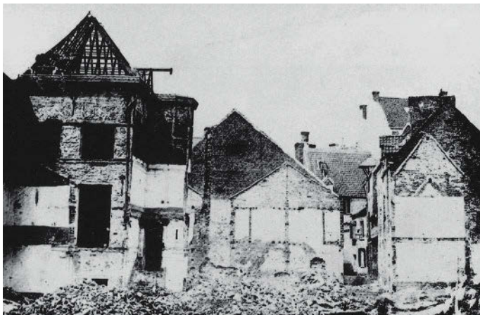
Slopingwerken tijdens de overwelving van de Zenne; rechts: wat er overblijft van de Waterpoortgang.
