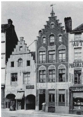
Het voormalige Kantersteen. Twee portieken aan weerszijden van een winkeltje geven toegang tot de Hellegang en de Maagdepalmgang.
