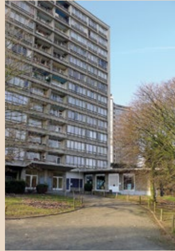
Het langwerpige appartementsgebouw met handelszaak op de benedenverdieping dat als enige gerealiseerd werd, naar een ontwerp van Brunfaut en Vanden Bossche. Op de achtergrond een klaverbladtoren. (foto Q. Nicolai)
