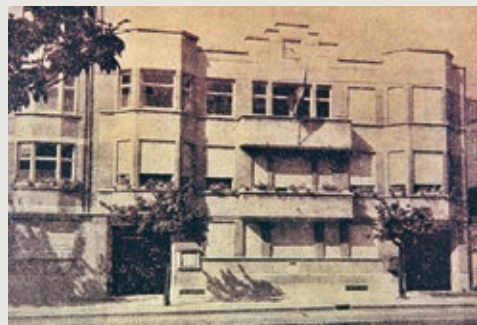
Het nieuw geïnstalleerde gemeentehuis in het vroegere gebouw van Radio Conférences et Concerts. Foto omstreeks 1958. (Archief van de Faculteit Architectuur van de ULB, Fonds De Coster)
