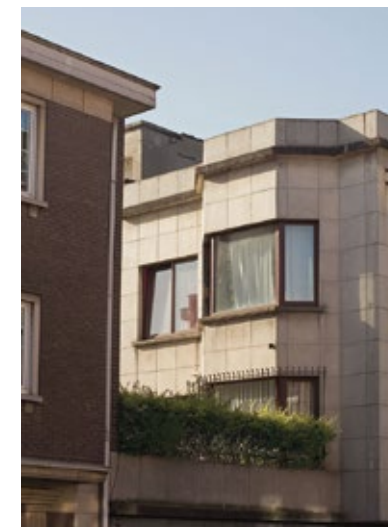
Appartementsgebouw met eigen woning van Jean Delhaye. Het achteraan gelegen terras houdt de hoek met de Amaryllisstraat open. (Foto A. de Ville-de Goyet ©MBHG)
