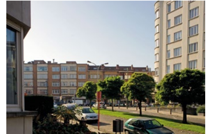
De Keizer Karellaan gezien vanuit de De Villegaslaan. Rechts, de witte bepleisterde gevel van de Résidence Basilique, ontworpen door Jean Delhaye, die contrasteert met de monotone gevels in geglazuurde baksteen die de rest van de laan kenmerkt. (Foto A. de Ville-de Goyet ©MBHG)
