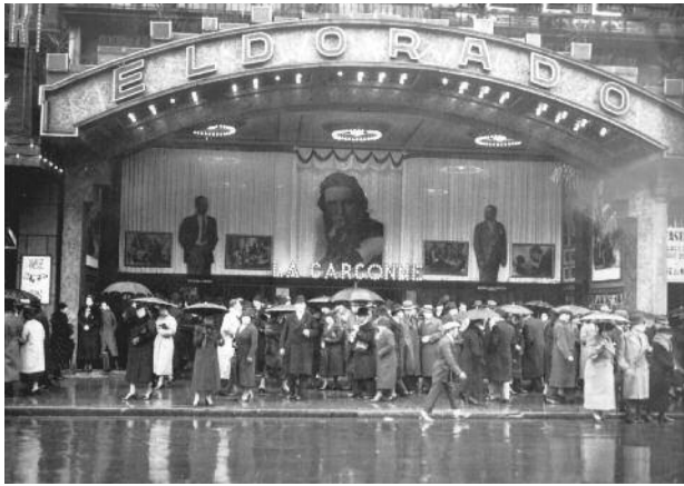
Eldorado: gevel aan het De Brouckèreplein, 1932 en 1938 (in Bâtir).
