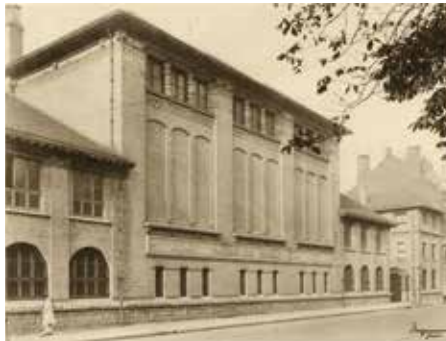
De Entreprises De Waele, zicht vanuit de Leopold II-laan, 1927. Links, de uitbreiding door Eugène Dhucque. Rechts, het herenhuis ontworpen door Émile Janlet. (L'émulation, 11, 1927, p. 129)
