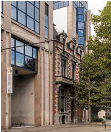
Zicht vanuit de Leopold II-laan op het herenhuis van Émile Janlet dat werd geïntegreerd in een modern kantoorgebouw. (A. de Ville de Goyet, 2022 © urban.brussels)
