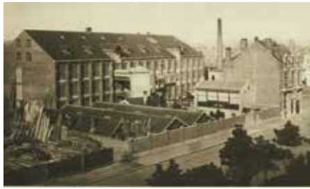
De Entreprises De Waele, zicht vanuit de Leopold II-laan, 1894. Links bevindt zich de Lavalléestraat met het fabrieksgebouw ontworpen door Henri Beyaert, rechts het herenhuis van Émile Janlet. (© AVB)
