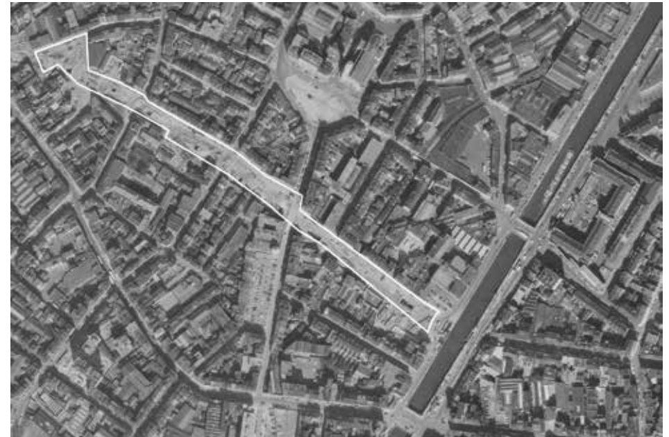
De aanleg van de metrolijn veranderde een groot deel van het centrum van Molenbeek in een enorme bouwwerf. (© http://Bruciel.brussels , 1977)
