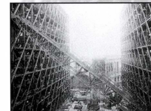
Montage van de steigers en de portaalkranen, januari 1905.
