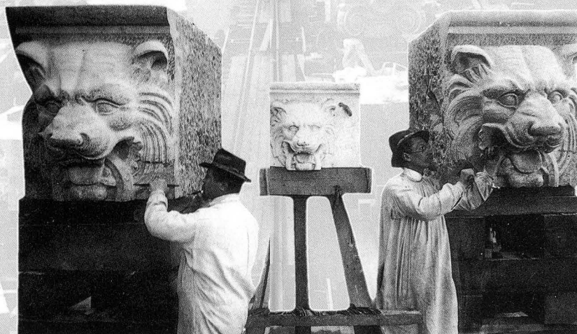
De blauwe hardsteen van Zinnik wordt in blokken aangevoerd op de werf beeldhouwd.
