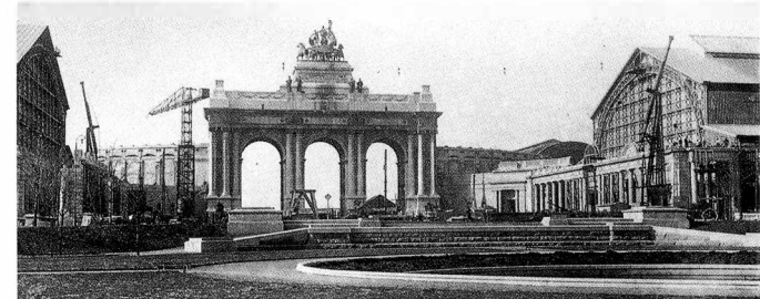
Boven links : Drie traveeën van de door G. Bordiau ontworpen hallen voor de Wereldtentoonstelling van 1897 worden afgebroken. Le Patriote Illustré van 20 juni 1909.
