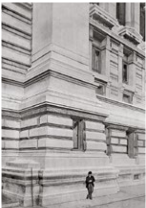
Detail van de achtergevel, waarbij de "cyclopische" schaal van het bouwwerk tegenover de menselijke gestalte erg duidelijk wordt.
