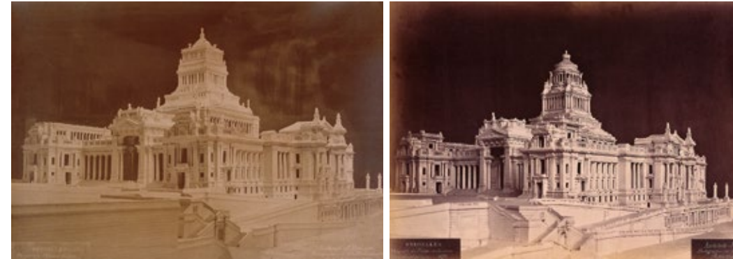
Fotografische opname van het schaalmodel van het Justitiepaleis. De koepelopbouw uit 1862 werd reeds meer monumentaal gemaakt door een tweede zuilengalerij.
