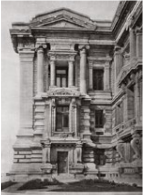
Fragment van de zijgevel gericht naar de Miniemenstraat, waarin de stapeling van kolommen en pilasters, de grootschalige profileringen van consoles, raamlijsten en frontons optimaal tot uitdrukking komt.
