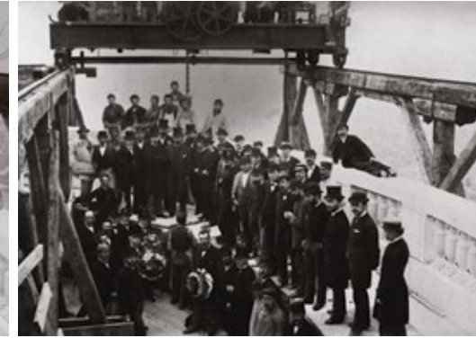
Laatste steenlegging van de koepelcilinder op 1 juli 1882, foto met de arbeiders en foto van de plechtigheid. De vijfde figuur met buischoed v.r.n.l. (midden onder) is ingenieur François Wellens (1812-1897), de zevende figuur met bloemenkrans is aannemer Devestel.
