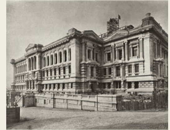
De steigers voor de opbouw van de koepelruimte.
