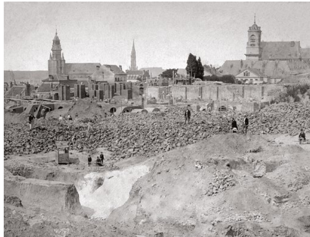
De bouwput en de grondwerken van het Justitiepaleis. Op de achtergrond v.l.n.r. de Kapellekerk, de toren van het gotische stadhuis, de Miniemenkerk.
