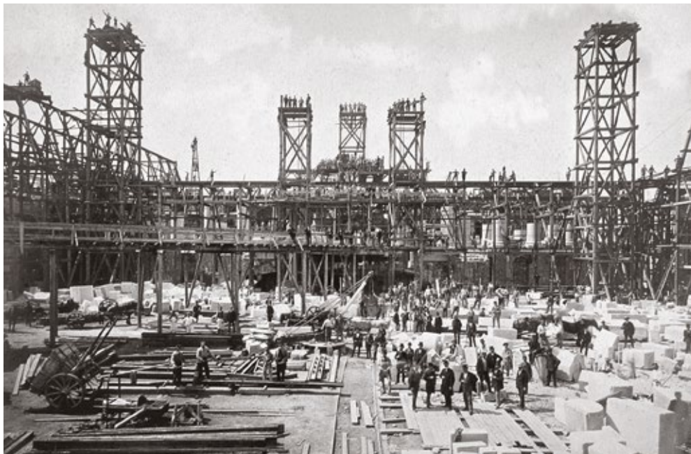
De bouwplaats en de steigerbouw.
