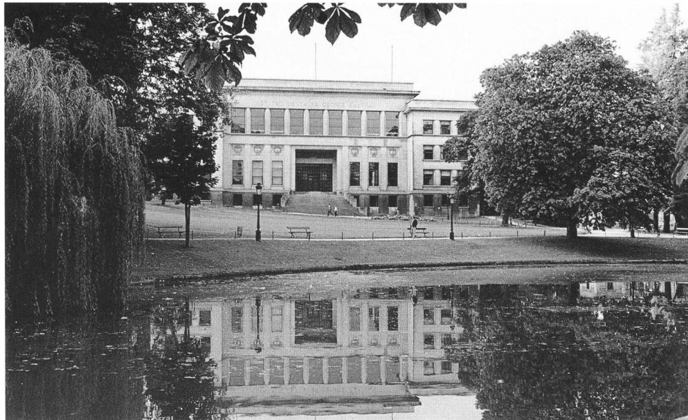
Het Eastman-Instituut, dat de plaats innam van het Instituut voor Hygiëne, is het laatste gebouw dat in het park werd gebouwd (1933-1935).
