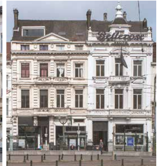
Sint-Gillis, geheel van een herenhuis en burgerwoningen, Charleroiesteenweg 5-9, arch. Hendrik Beyaert, 1862. (A. de Ville de Goyet © GOB)
