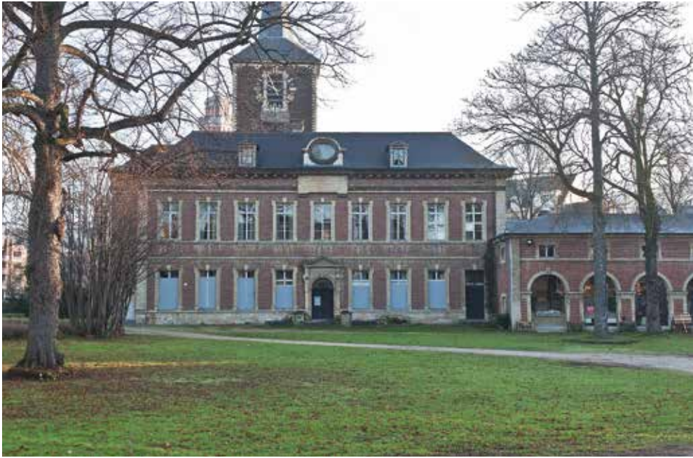
Abdy van Vorst, vanaf 1764 (onvoltooid), arch. L.-B. Dewez. (A. de Ville de Goyet © GOB)
