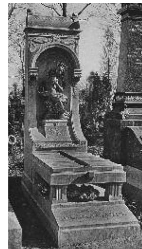
Grafmonument voor de familie Wouters-Dustin door Joseph Caluwaers en Jules Lagae, 1904 ( L'Émulation , 1906).
